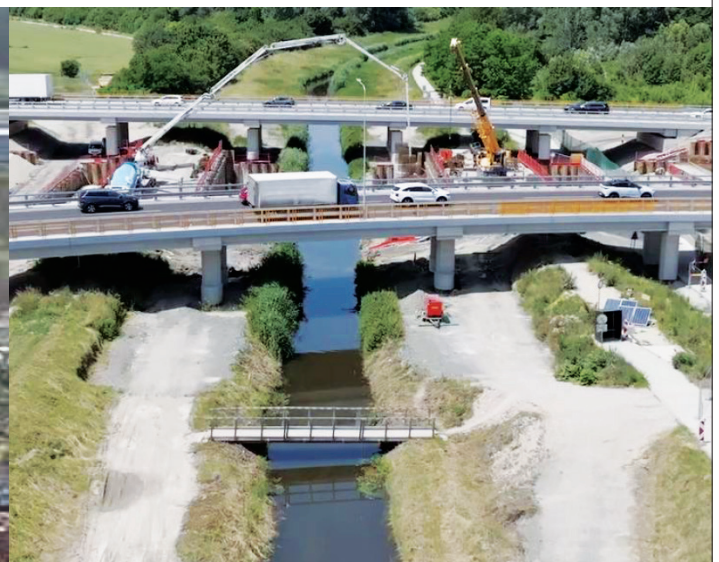
Obr. 7 Most na kolektorovom páse vedúci ponad Šúrsky kanál Fig. 7 Bridge on the collector road over the Šúrsky Canal
