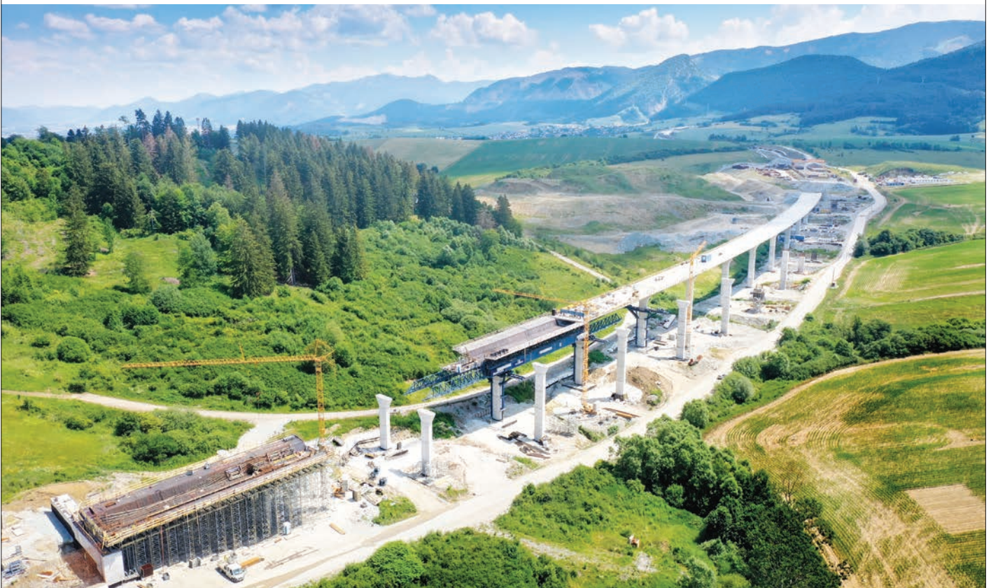
Obr. 4 Postupná výstavba mostu Fig. 4 Progressive construction of the right bridge
