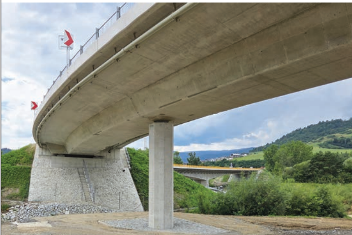
Obr. 3 SO 210 počas výstavby Fig. 3 SO 210 during construction
