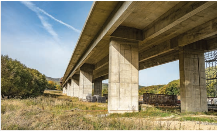
Obr. 1 Pohľad na spodnú stavbu mosta Fig. 1 A view of the flyover substructure
