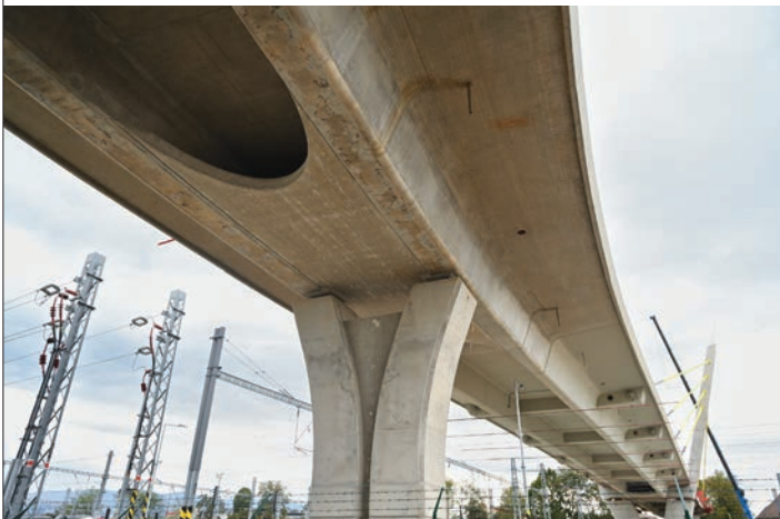
Obr. 3 Eliptické spodné dosky – pilier P5 (zdroj: Jarmila Uhlíková) Fig. 3 Elliptical base plates – P5 pillar (source: Jarmila Uhlíková)
