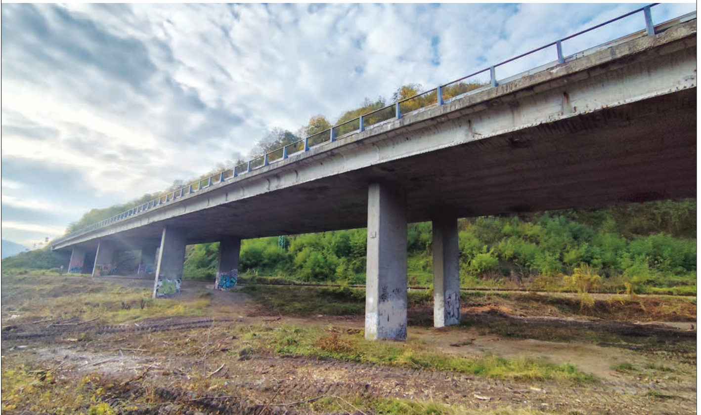
Obr. 1 Pohľad na most Fig. 1 View of the bridge
