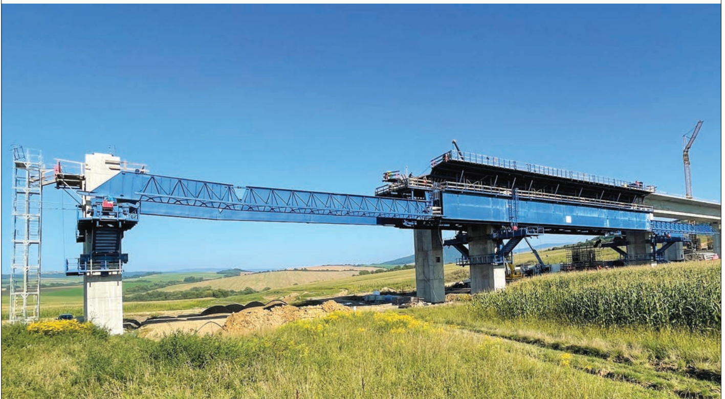
Obr. 4 Nasadenie spodnej výsuvnej skruže systému STRUKTURAS na pravom moste SO 201-00
