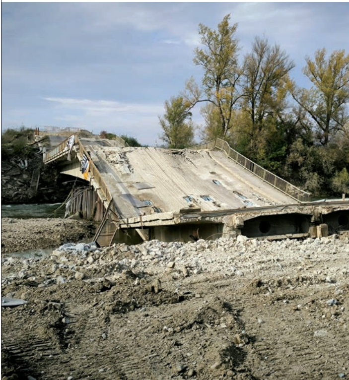
Obr. 5 Demolícia nosnej koňštrukcie nad Váhom stav po odstrele Fig. 5 Demolition of the superstructure over the Váh River after blasting
