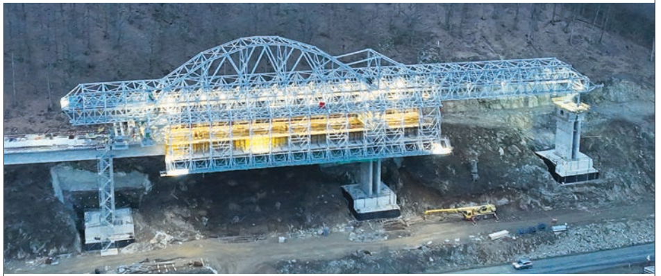
Obr. 3 Úsek R2 Kriváň – Mýtina, SO 209 02 sa realizoval pomocou výsuvnej skruže BERD v kombinácii s Doka nosníkovým debnením Top 50.
