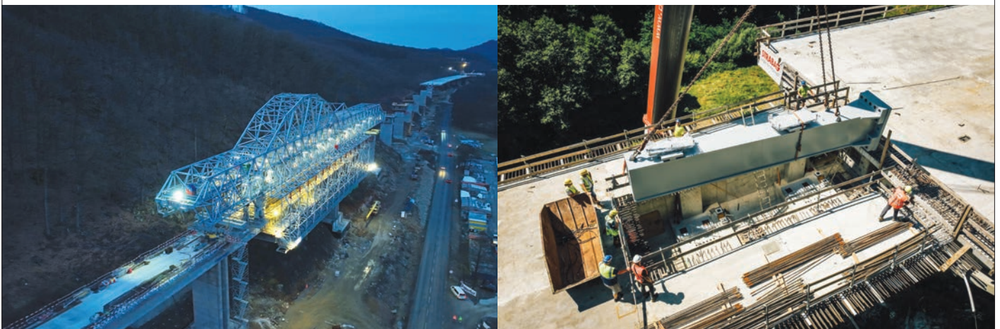
Obr. 6 Pohľad na MSS a montáž dilatačného nosníka Fig. 6 View of the MSS and installation of the expansion beam
