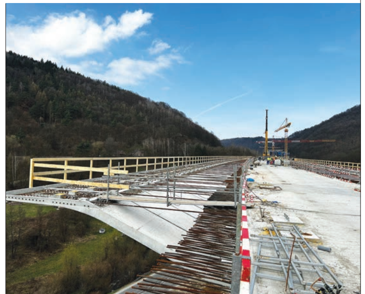
Obr. 7 Pohľad na montáž vzpier Fig. 7 Installation of struts
