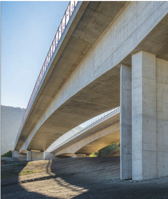
Obr. 4 Konstrukce mostu Fig. 4 Bridge structure
