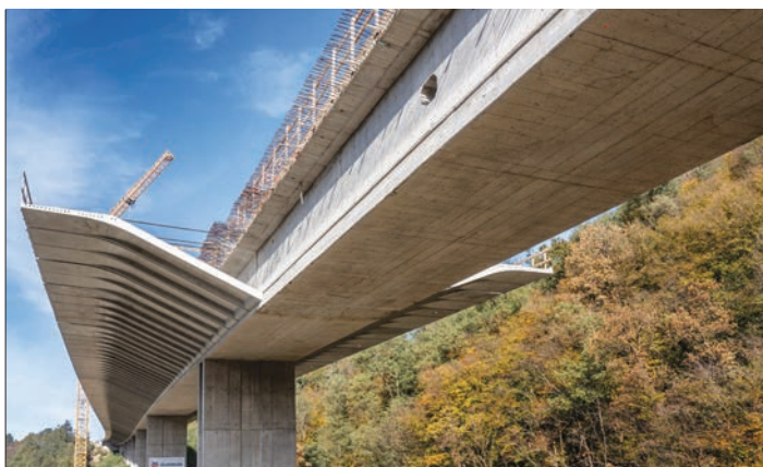
Obr. 4 Vzpěry typického pole Fig. 4 Typical span's struts
