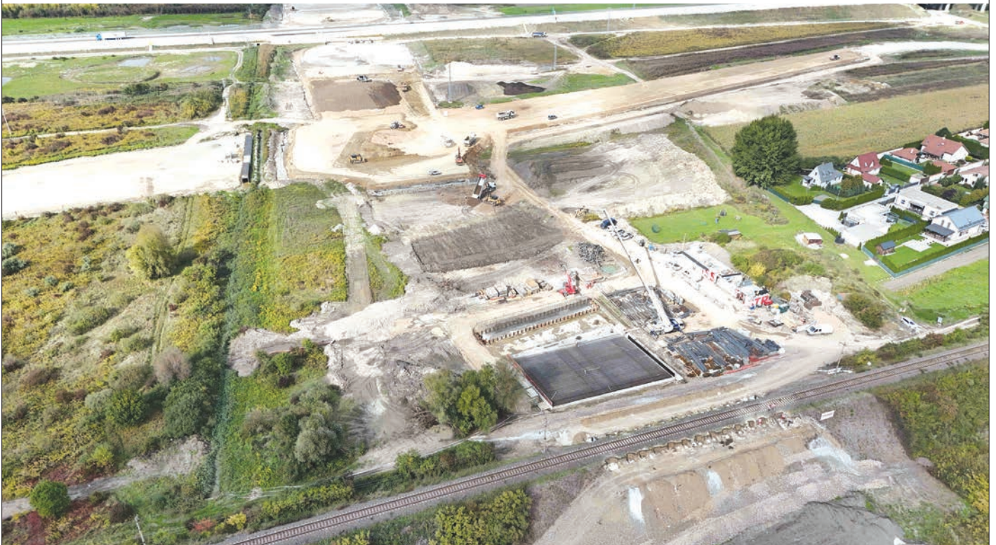
Obr. 3 Pohľad na rozostavaný objekt SO 421
