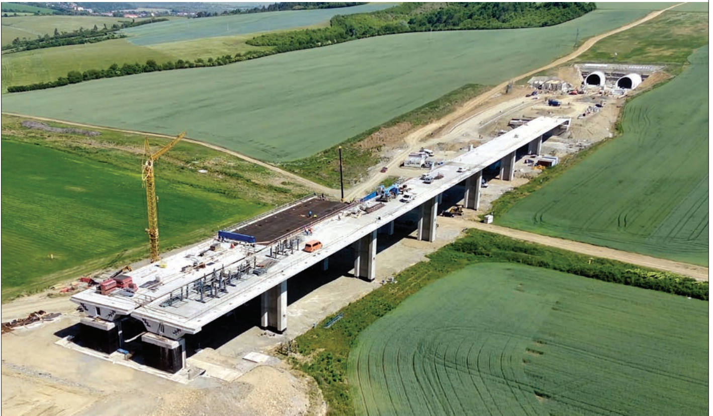
Obr. 5 Realizácia SO 201-00 výsuvnou skružou, v pozadí južný portál tunela Bikoš
