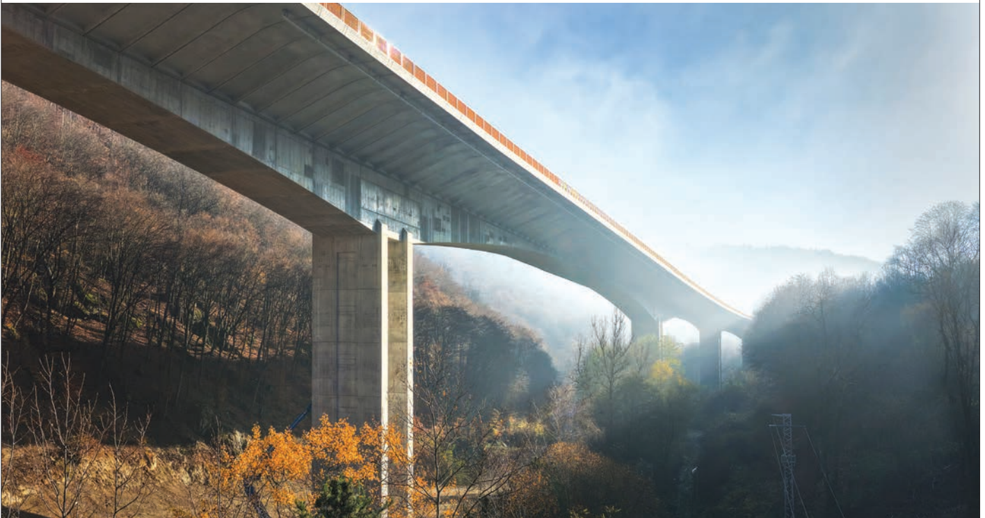
Obr. 10 Letmo betonovaný most s rozpětím 150 m
