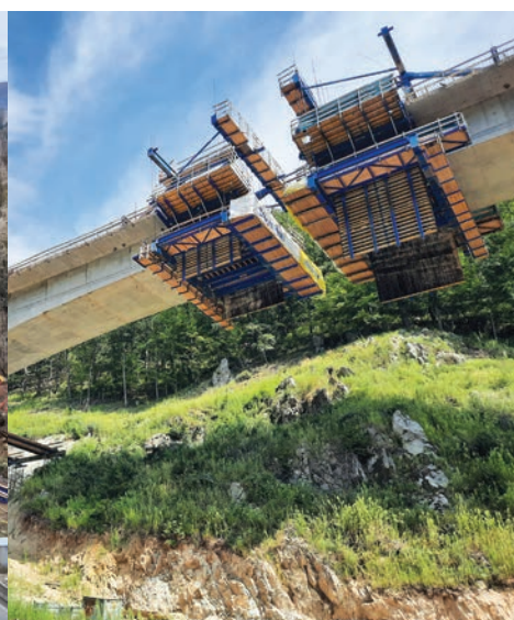
Obr. 2 Výstavba R2 Kriváň – Mýtina, SO 209 01 realizovaný pomocou 3 párov Doka-vozíkov pre letmú betonáž.
