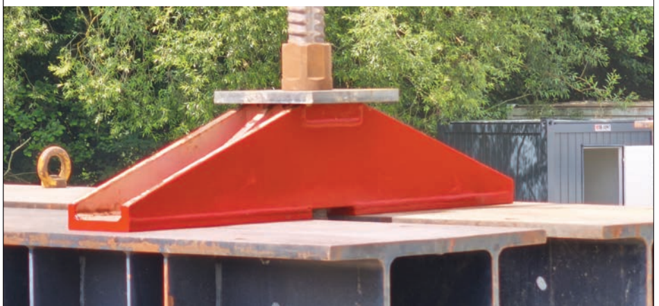
Obr. 6 Ukotvenie pomocou predpinacích lán alebo GEWI tyčí
