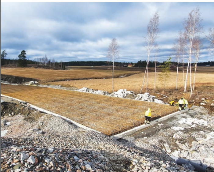
Obr. 6 Trne PSB použité v hlavách pilót, Turku, Fínsko, 2021 Fig. 6 PSB Headed bars used in pile caps, Turku, Finland 2021
