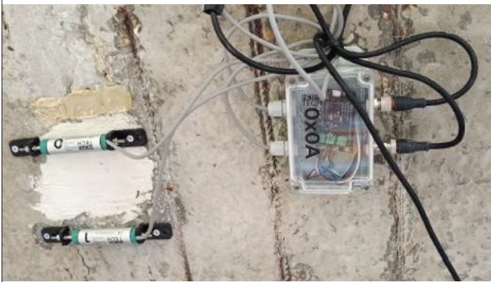
Obr. 9 Pohľad na jednu z monitorovaných škár Fig. 9 View of one of the monitored joints
