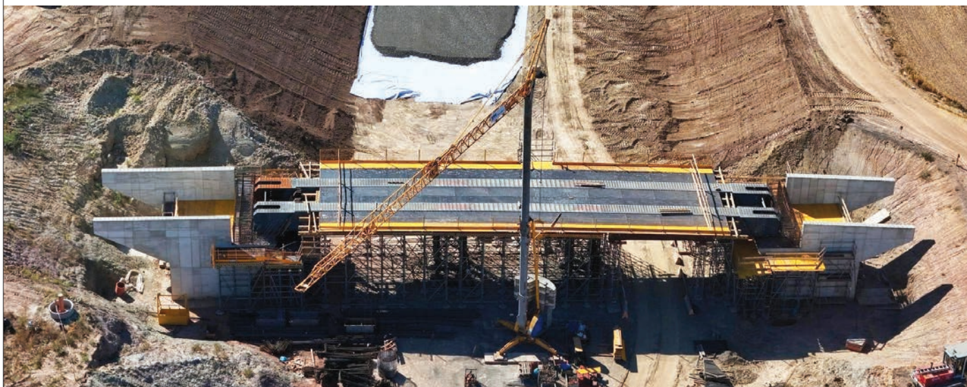
Obr. 1 Pohľad na nosnú konštrukciu počas osádzania debnenia spriahajúcej dosky
