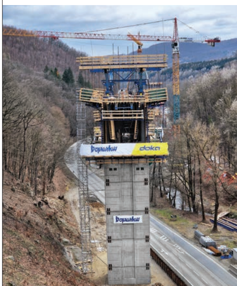
Obr. 2 Výstavba R2 Kriváň – Mýtina, SO 209 01 realizovaný pomocou 3 párov Doka-vozíkov pre letmú betonáž.
