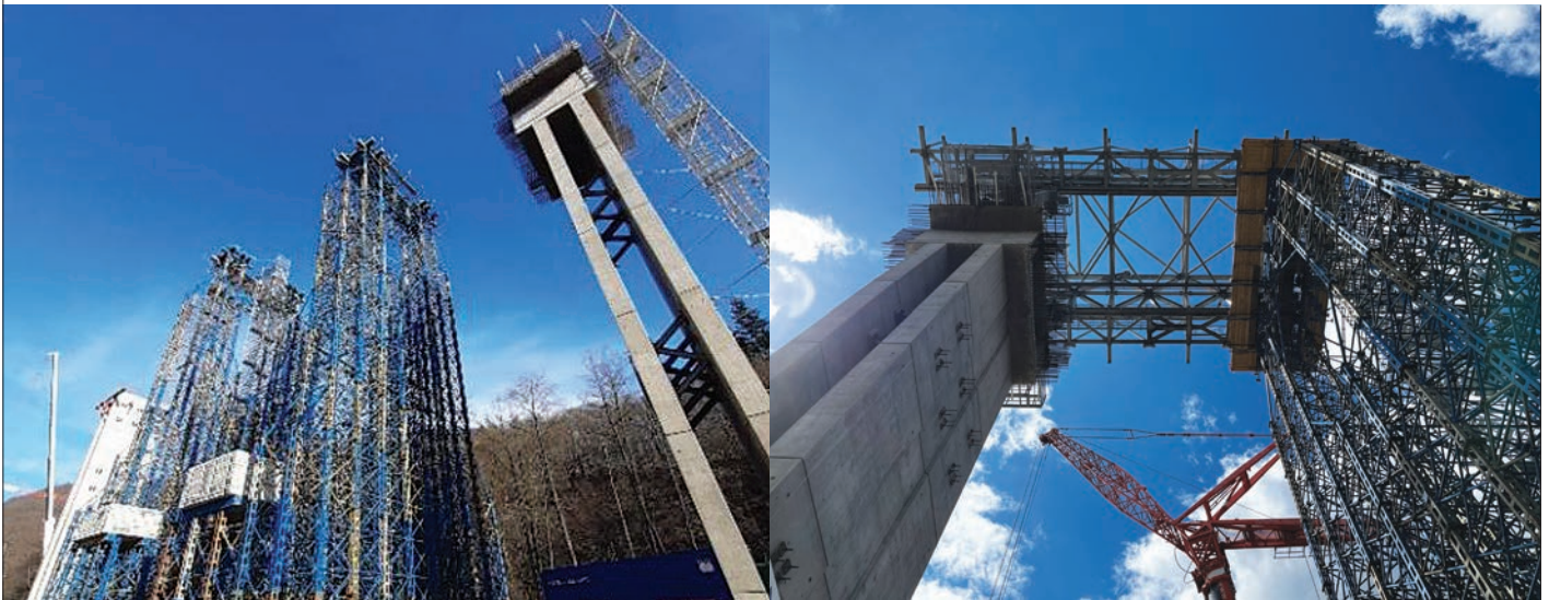
Obr. 5 Dočasná montážna plošina Fig. 5 Temporary work platform
