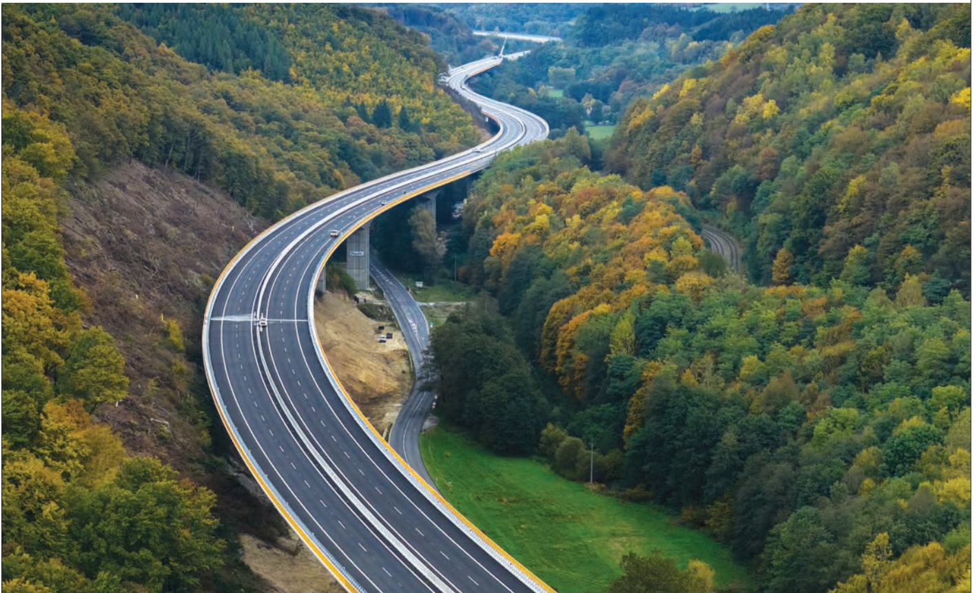
Obr. 1 Viadukt Kriváň – Mýtina Fig. 1 Viaduct Kriváň – Mýtina
