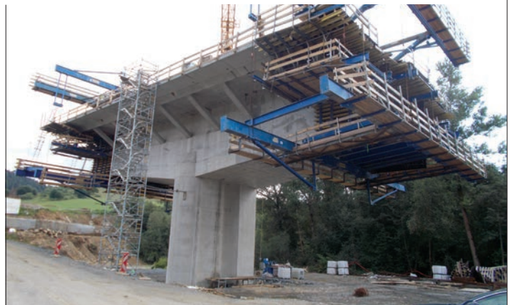
Obr. 5 SO 211, zárodok s 2. etapou letnej betonáže Fig. 5 SO 211, balanced cantilever during construction
