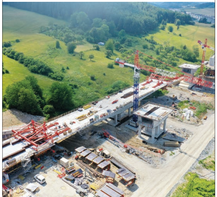
Obr. 5 Postupná výstavba mostu Fig. 5 Progressive construction of the right bridge
