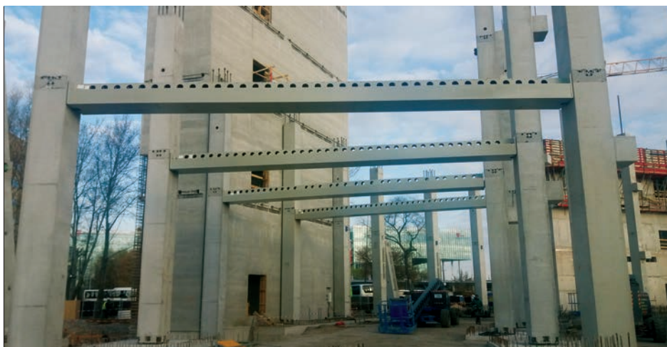
Kotvenie stĺpov v MVM Dome, Budapešť
