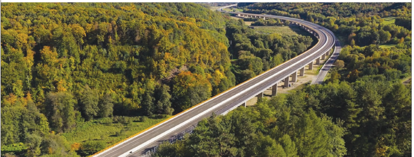
Obr. 6 Pohľad na hotový most
