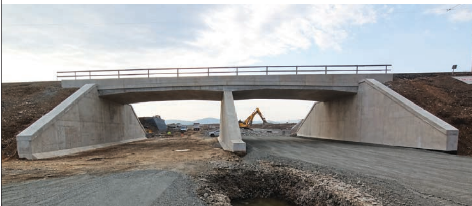
Obr. 5 Stav mosta pred realizáciou vozovky objektu komunikácie SO 111
