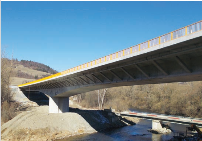
Obr. 7 SO 211, dokončená stavba Fig. 7 SO 211, completed structure
