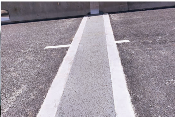
Inštalácia jedného zo 14 DZ TENSA®POLYFLEX®Advanced PU.
