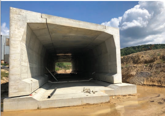
Obr. 2 Pohľad na poskladaný objekt SO 201 vľavo, priečny rez vpravo Fig. 2 The assembled SO 201 structure on the left, cross-section on the right
