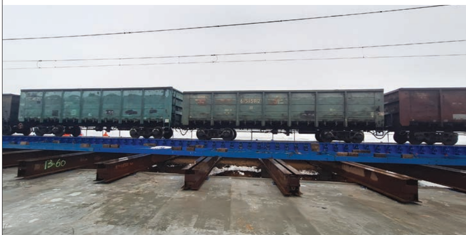
Obr. 3 Mostné provizorium (systém Verona) počas prevádzky na ŠRT
