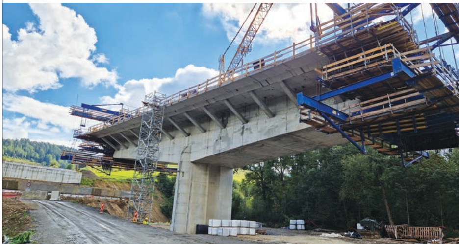
Obr. 1 Most nad riekou Orava na R3 Tvrdošín – Nižná nad Oravou, SO 211 sa realizoval pomocou Doka-vozíkov pre letmú betonáž.
