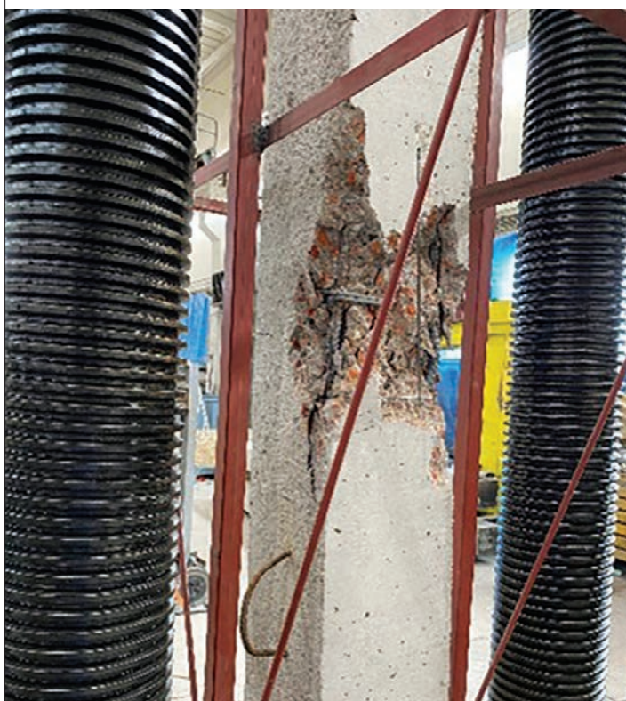
Obr. 5 Porušenie štíhleho stĺpa Fig. 5.1 Failure of slender column
