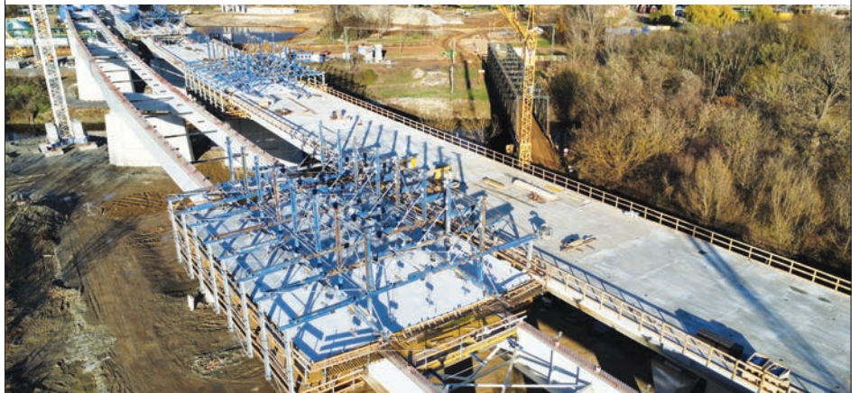
Obr. 4 Doka-spriahnuté debniace vozíky pri výstavbe D1 Říkovice – Přerov, SO 209
