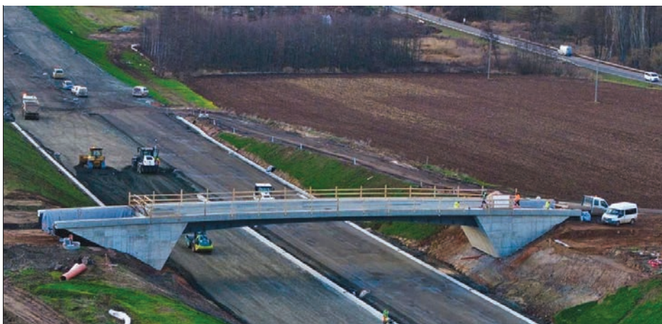
Obr. 2 Pohľad na most SO 221 nad D6 Lubenec – obchvat (SO 3-101) po odskrúžení
