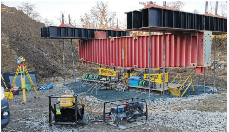
Obr. 5 Zafažovacia konštrukcia počas skúšky
