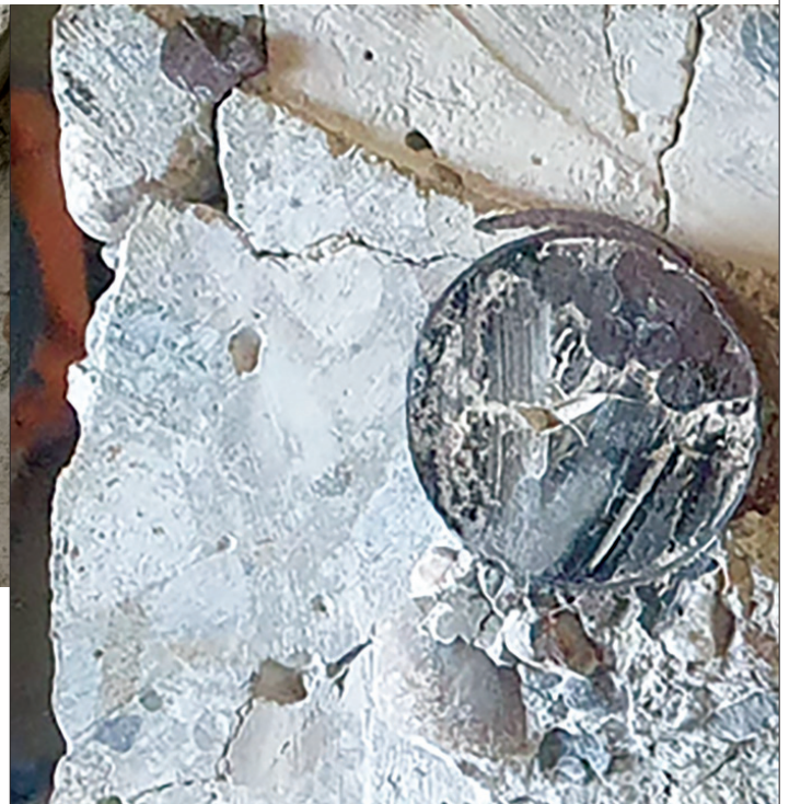
Obr. 5 Rez káblovým kanálikom s injektážou
