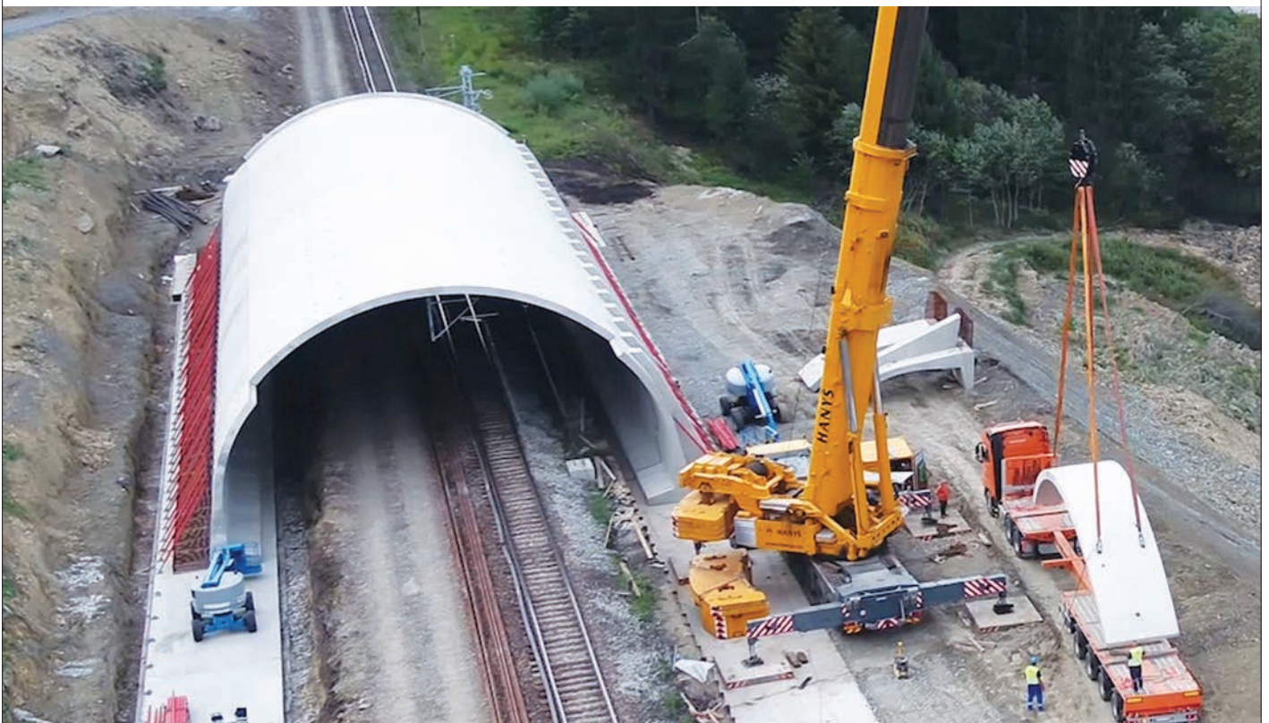
Obr. 4 Montáž prefabrikovaných dielcov žeriavom s nosnosťou 500 t Fig. 4 Installation of prefabricated elements using a crane with a capacity of 500 t
