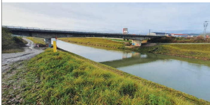
Obr. 1 Pohľad na pôvodný most nad Biskupickým kanálom Fig. 1 View of the original bridge over the Biskupický Canal
