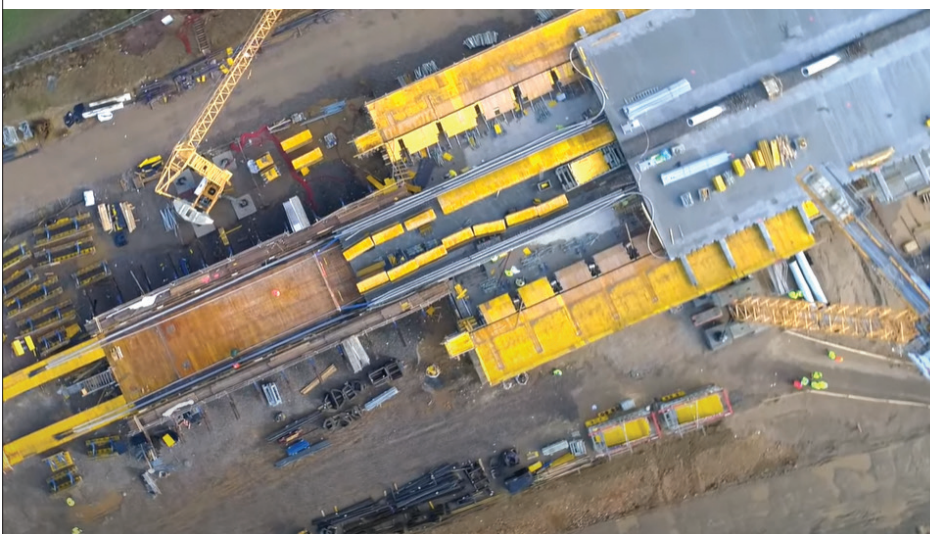
Obr. 5 Pohľad na „výrobňu“ vysúvania a odlatie lamely mostovky na ceste I/36 Pardubice, Trnová – Fáblovka – Dubina.
