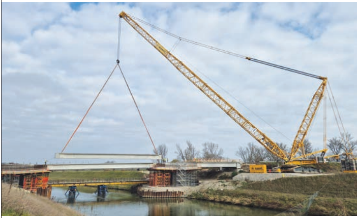
Obr. 3 Montáž nosníkov stredného poľa nad kanálom Fig. 3 Installation of the beams of the central span over the canal
