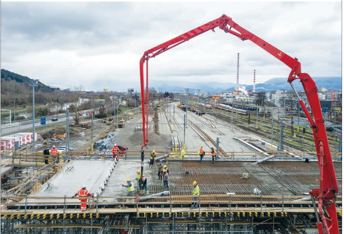
Obr. 4 Betonáž poľa 4 (zdroj: STRABAG, s. r. o.)
