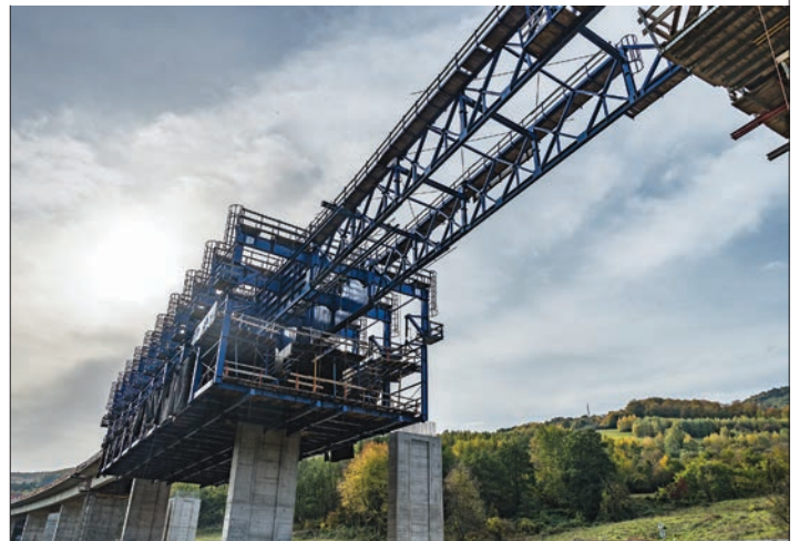
Obr. 5 Horná výsuvná skruž ľavého mosta
