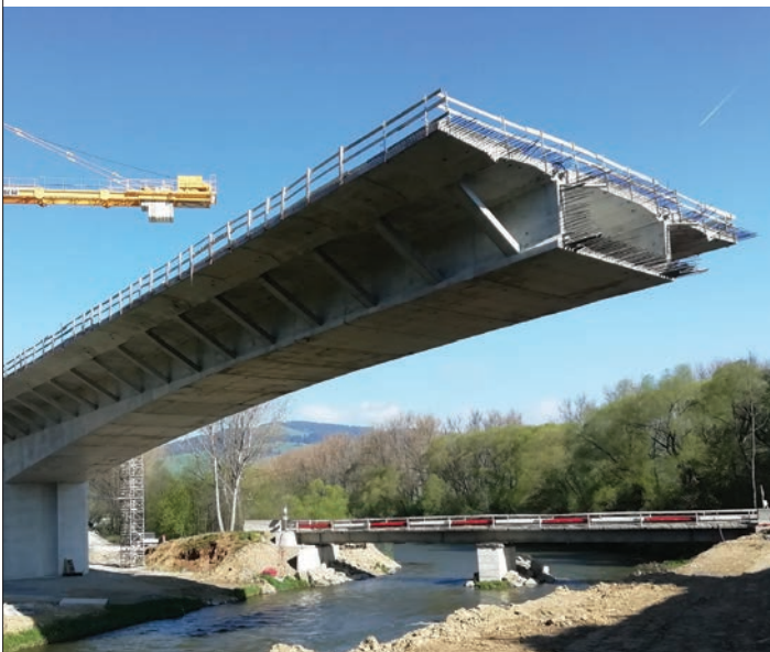
Obr. 6 SO 211, odstránenie vozíkov letnej betonáže po poslednej etape Fig. 6 SO 211, finished balanced cantilever
