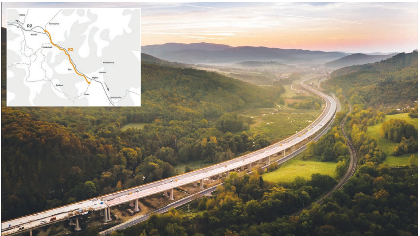
Obr. 1 Novobudovaný úsek R2 Kriváň – Mýtina Fig. 1 Newly constructed section of the R2 Kriváň and Mýtina
