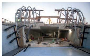
FIG. 7 Vista de uma das fases correspondente à construção de um dos segmentos. View of one of the phases corresponding to the construction of one of the segments.
