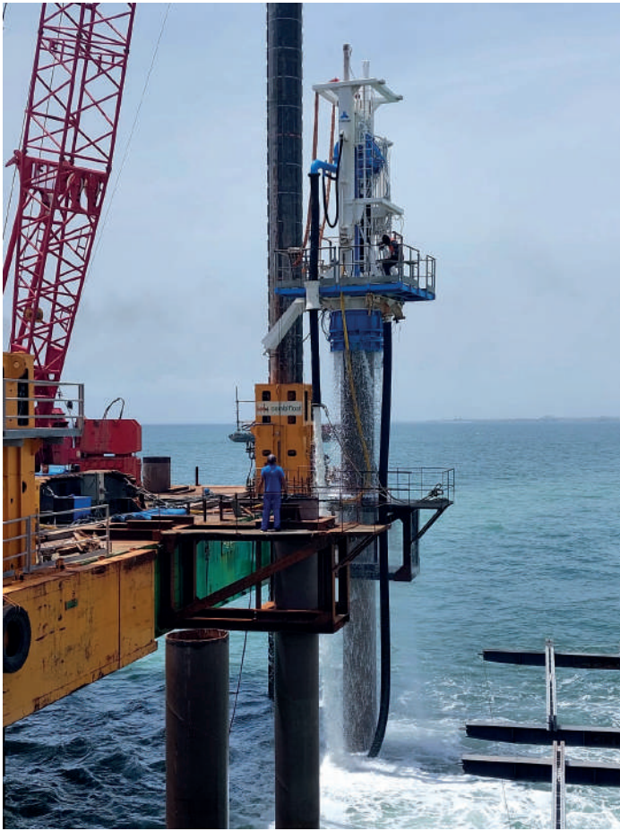
FIG. 3 Colocação estacas. Piles Placement.
