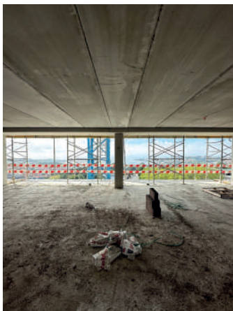
FIG. 4 Interior do edifício durante a construção. Building interior during construction.
