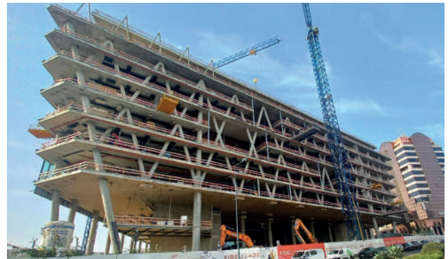
FIG. 5 Vista da treliça da fachada principal. View of the main façade.
