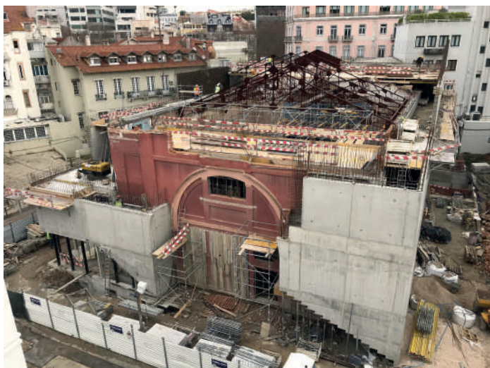
FIG. 1 Construção de envolvente de betão armado. Construction of the reinforced concrete shell.
