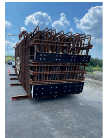
FIG. 9 Prefabricação das armaduras de um dos diafragmas. Prefabrication of the reinforcement for one of the diaphragms.
