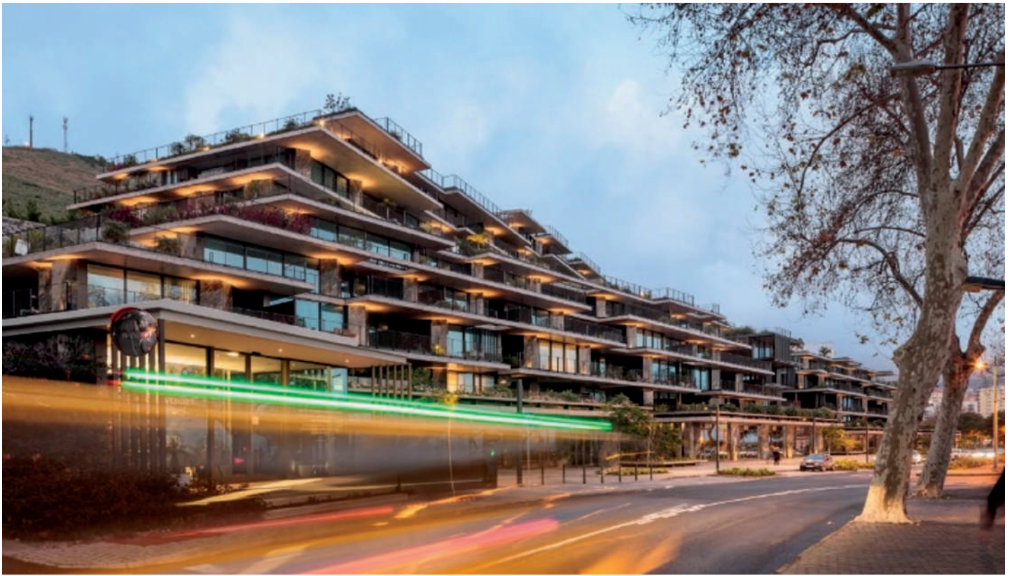
FIG. 2 Bloco Sul, visto de poente, com zona de sobreposição do Bloco Norte, nos pisos elevados. South block from West, overlapped with the North block. Upper levels.
