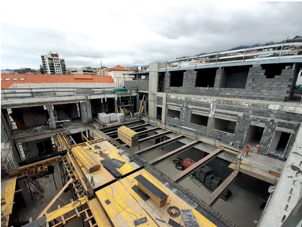
FIG. 4 Execução cofragem dos novos pisos intermédios. New floors, formwork, partial view after completion.
