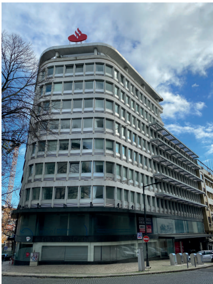
FIG. 3 Edifício antes da intervenção de adaptação e reforço. Building before the refurbishment and reinforcement interventions.
