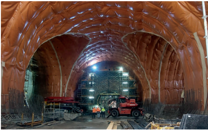
FIG. 3 Intersecção da Nave principal e Galerias transversais – Sistema de impermeabilização. Intersection of the main and transverse galleries – Waterproofing system.
