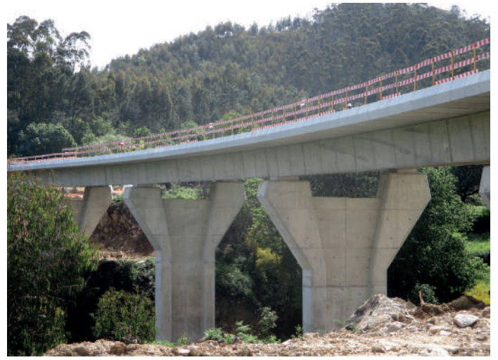
FIG. 5 Viaduto de Monte Calvo. Monte Calvo Viaduct.
