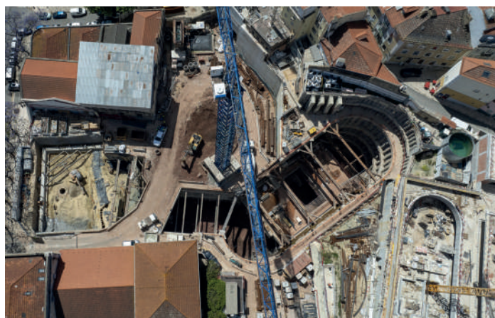
FIG. 2 Vista aérea do poço principal a céu aberto e envolvente. Aerial view of the main shaft and surroundings.
