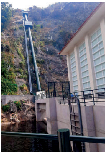
FIG. 4 Central e Conduita forçada. Powerhouse and Penstock.
