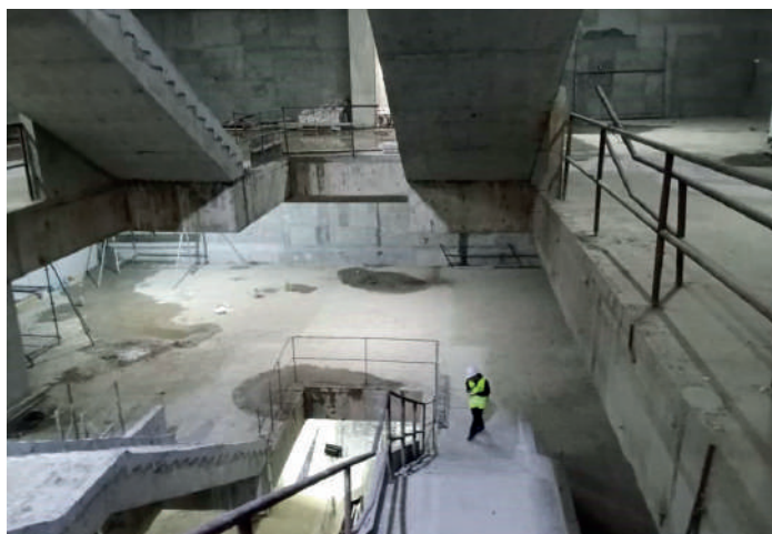
FIG. 5 Estação de Hacen Badi – Vista do poço lateral. Hacen Badi Station – Lateral shaft view
