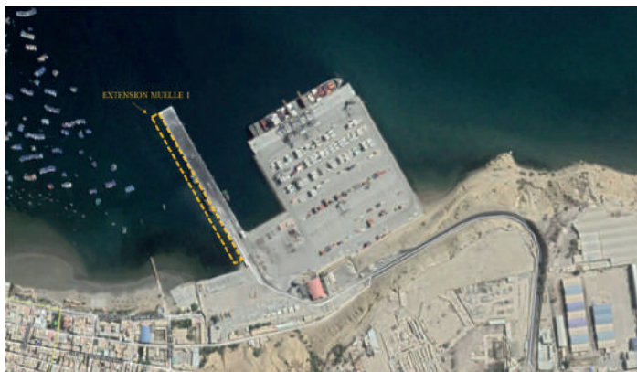
FIG. 1 Vista aérea implantação obra. Aerial view of project site layout.
