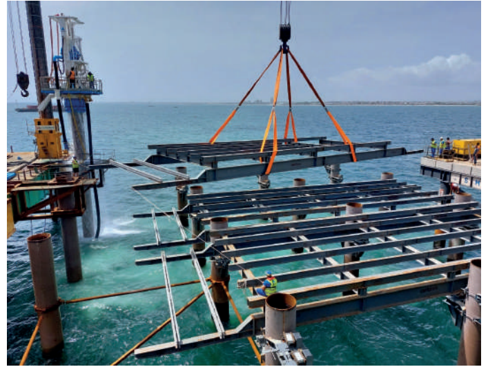
FIG. 4 Colocação cimbre. Formwork placement.
