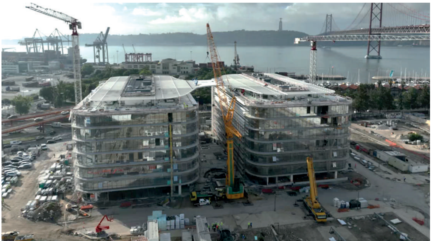
FIG. 1 Vista da obra durante a construção. Construction Works.
