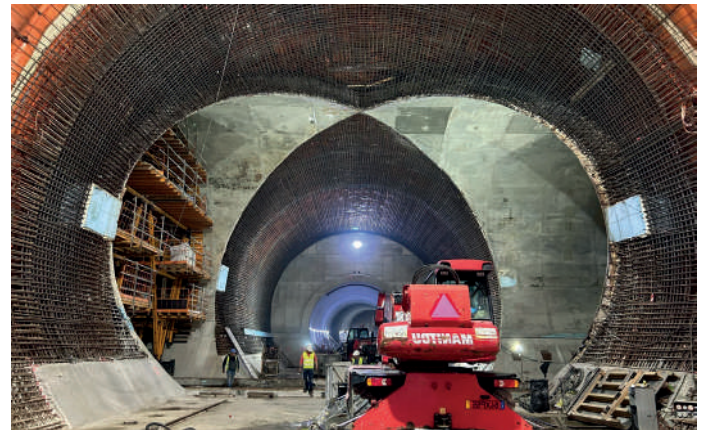
FIG. 4 Intersecção da Nave principal e Galerias transversais – Execução do revestimento definitivo. Intersection of the main and transverse galleries – Definitive lining.
