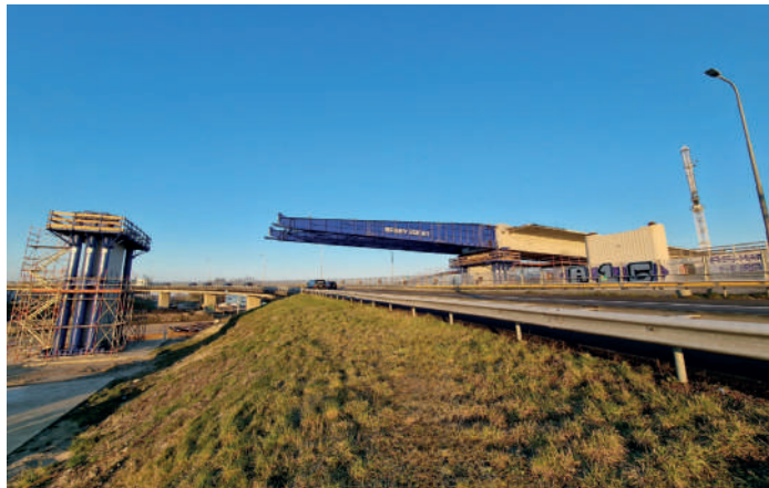
FIG. 3 Vista de uma das fases intermedia dos processo de lançamento incremental. View of one of intermediate launching steps.
