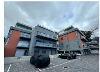
FIG. 5 Vista parcial após conclusão. Partial view after completion.
