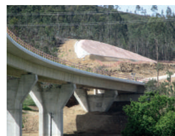
FIG. 3 Viaduto de Vilarinho – Encontro Sul. Vilarinho Viaduct – South Abutment.
