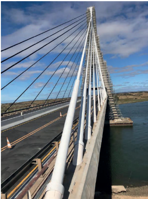
FIG. 3 Vista torre e tirantes durante reabilitação. View of tower and stay cables during rehabilitation.
