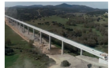
FIG. 4 Ponte do Lucefece. Lucefece Bridge.
