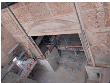
FIG. 5 Caixa de palco original antes de reforço. Original stage house before retrofitting.
