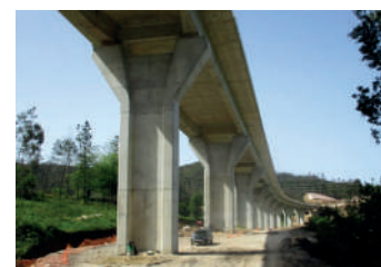
FIG. 2 Viaduto de Vilarinho – Vista inferior. Vilarinho Viaduct – Bottom View.
