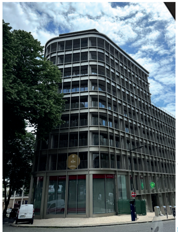
FIG. 4 Vista após conclusão da obra. View after completion.
