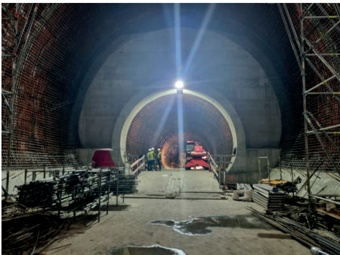
FIG. 5 Tímpano Sul da Estação. South tympanum of the station.
