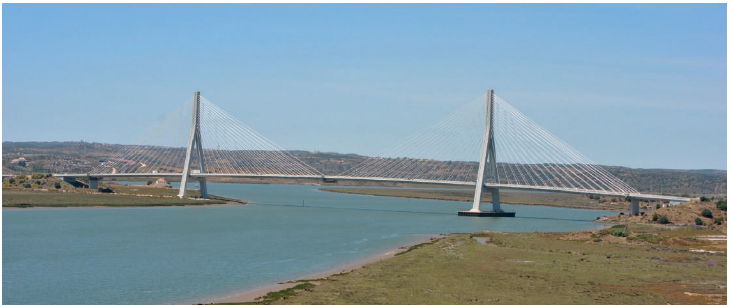
FIG. 5 Vista da ponte pós reabilitação. View of bridge after rehabilitation.
