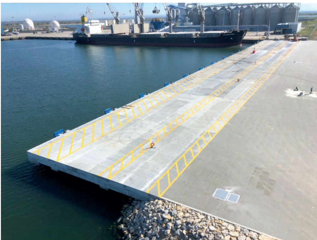
FIG. 4 Vista geral do cais finalizado. General view of the finished quay.
