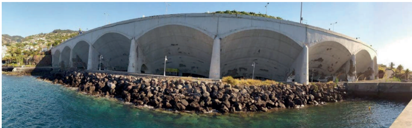
FIG. 1 Vista geral da estrutura antes da intervenção. General view of the structure before the intervention.
