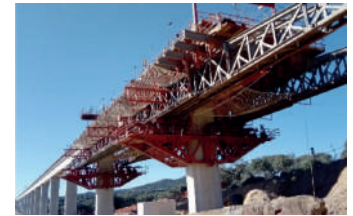
FIG. 6 Viga de Lançamento. Movable Scaffolding System.
