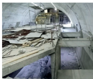
FIG. 7 Estação de Hacen Badi – Vista da galeria. Hacen Badi Station – Gallery view.
