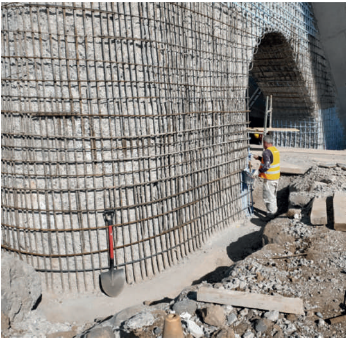
FIG. 2 Reabilitação dos contrafortes. Counterfort rehabilitation.
