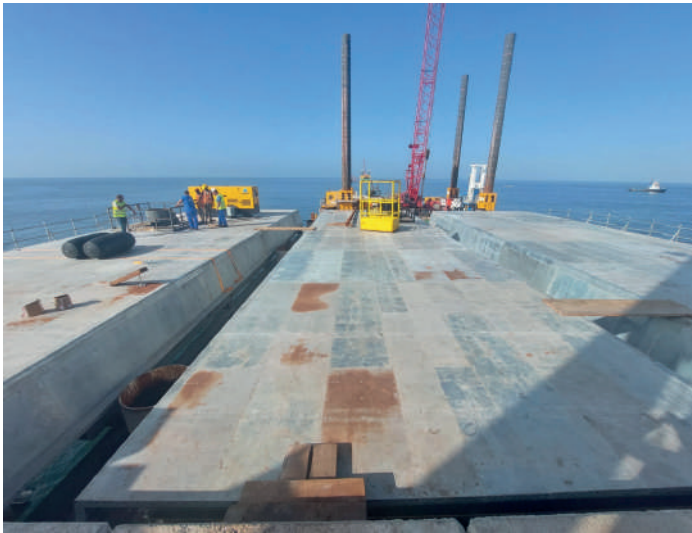
FIG. 5 Colocação cofragem. Formwork placement.
