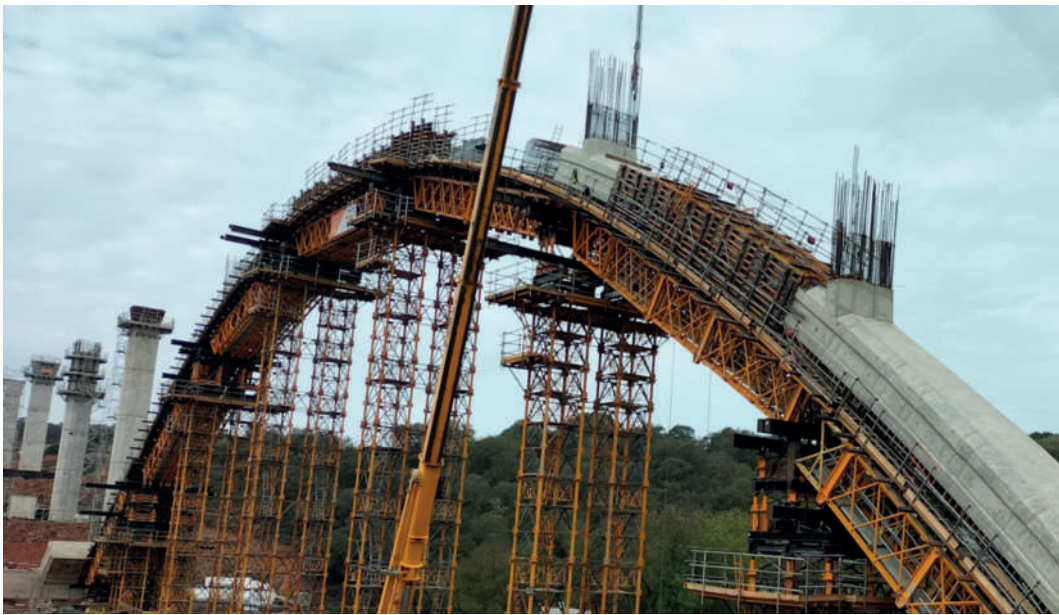
FIG. 2 Processo Construtivo – Execução do Arco. Arch Construction procedure – Arch.
