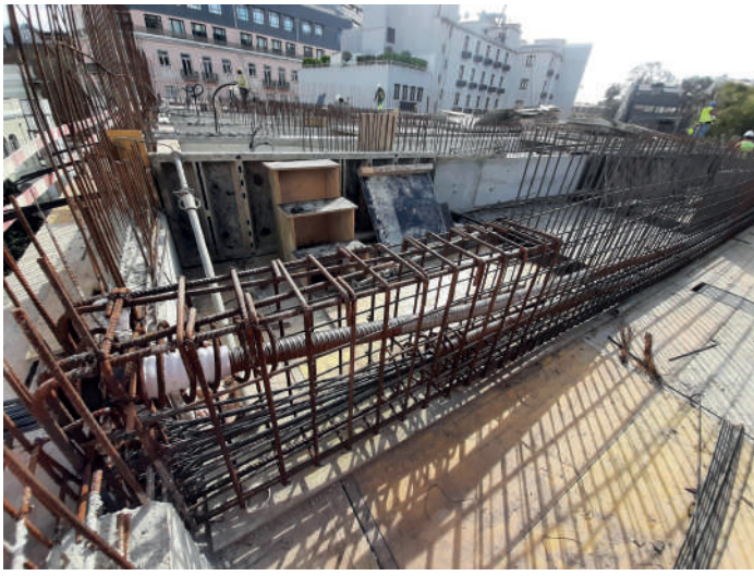
FIG. 3 Pré-esforço em vigas da cobertura. Post-tensioning in roof beams.
