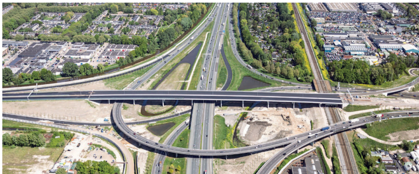
FIG. 1 Vista aérea do Viaduto K52A. Aerial view of Viaduct K52A.
