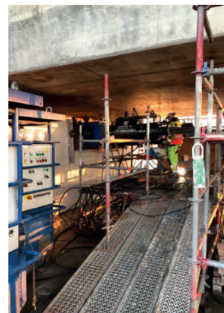
FIG. 8 Macaco hidráulico e sistema de pré-esforço usado para o lançamento incremental. Hydraulic jack and prestressing system used on incremental launching.
