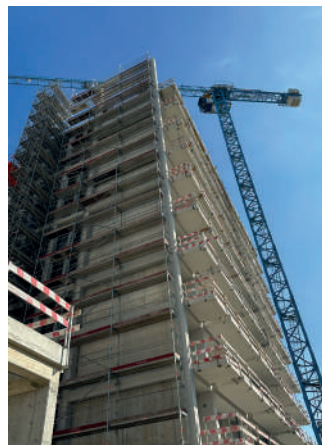
FIG. 5 Varandas durante a construção. Balconies during construction phase.
