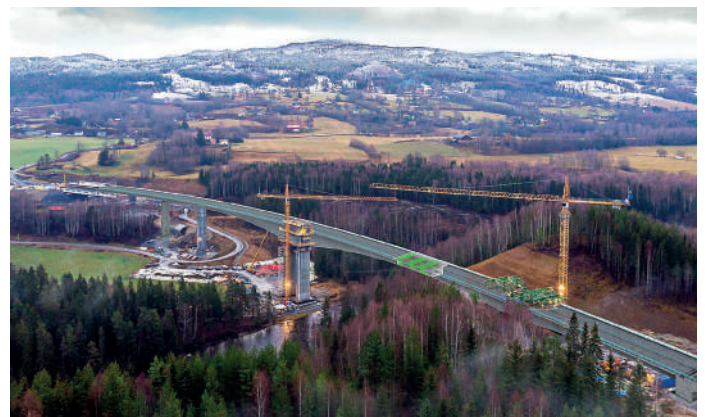
FIG. 3 Sobreposição de imagem da construção com o modelo BIM. Superposition of an image during construction with the BIM model.
