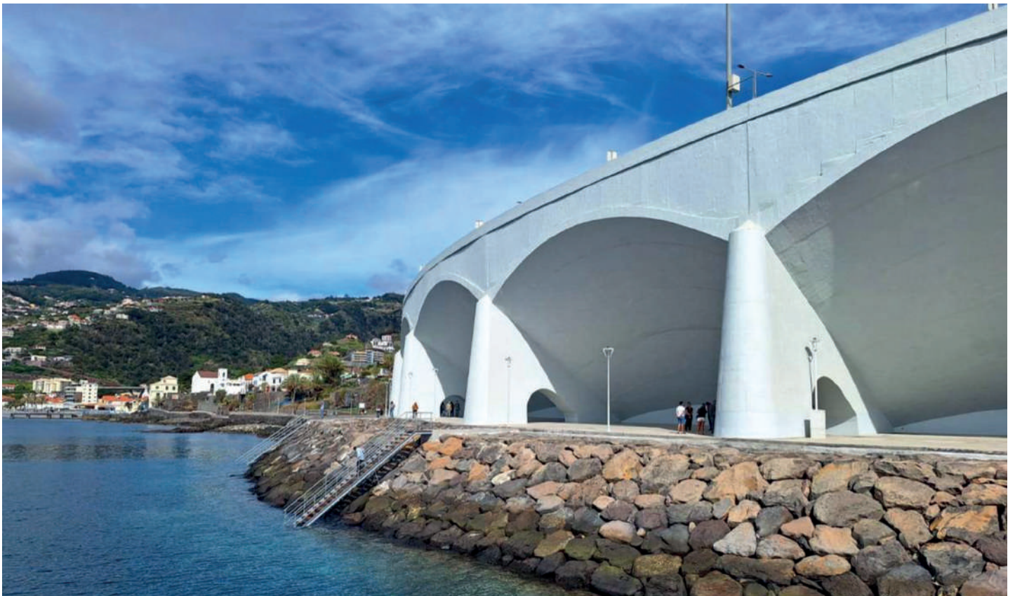
FIG. 3 Perspetiva Geral da Obra Acabada. General View of Finished structure.
