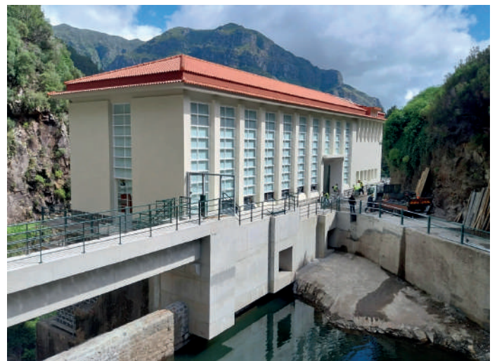
FIG. 5 Vista da central. Powerhouse view.
