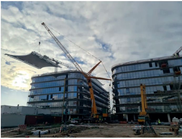
FIG. 2 Montagem da pala que une os edifícios. Steel roof connecting buildings.
