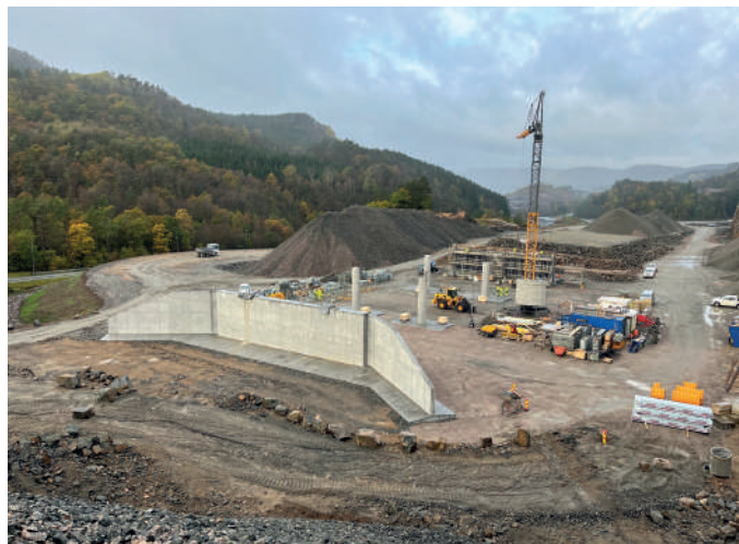
FIG. 5 A obra aquando da construção dos encontros e pilares. Bridge during works – abutments and piers.
