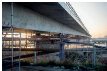
FIG. 5 Vista do processo de lançamento incremental do viaduto. View of the viaduct launching process phase.
