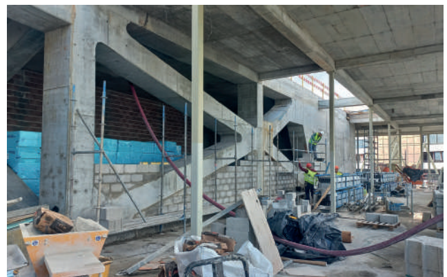
FIG. 7 Vista parcial da viga de transição 1. Partial view of the transfer beam 1.
