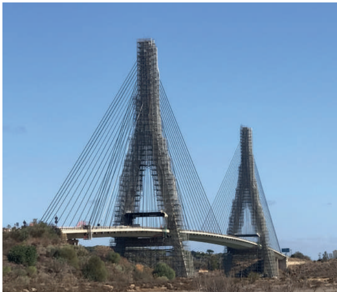
FIG. 1 Vista geral ponte durante reabilitação. General view of the bridge during rehabilitation.
