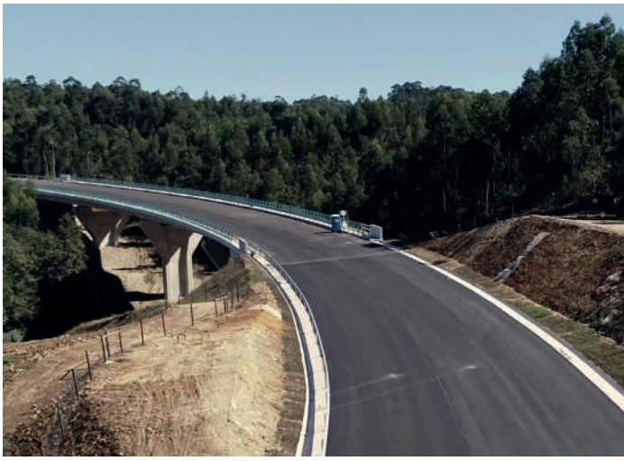
FIG. 4 Viaduto de Escariz. Escariz Viaduct.
