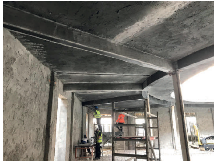
FIG. 4 Laje da plateia durante trabalhos de reforço. Auditorium slab during retrofitting works.
