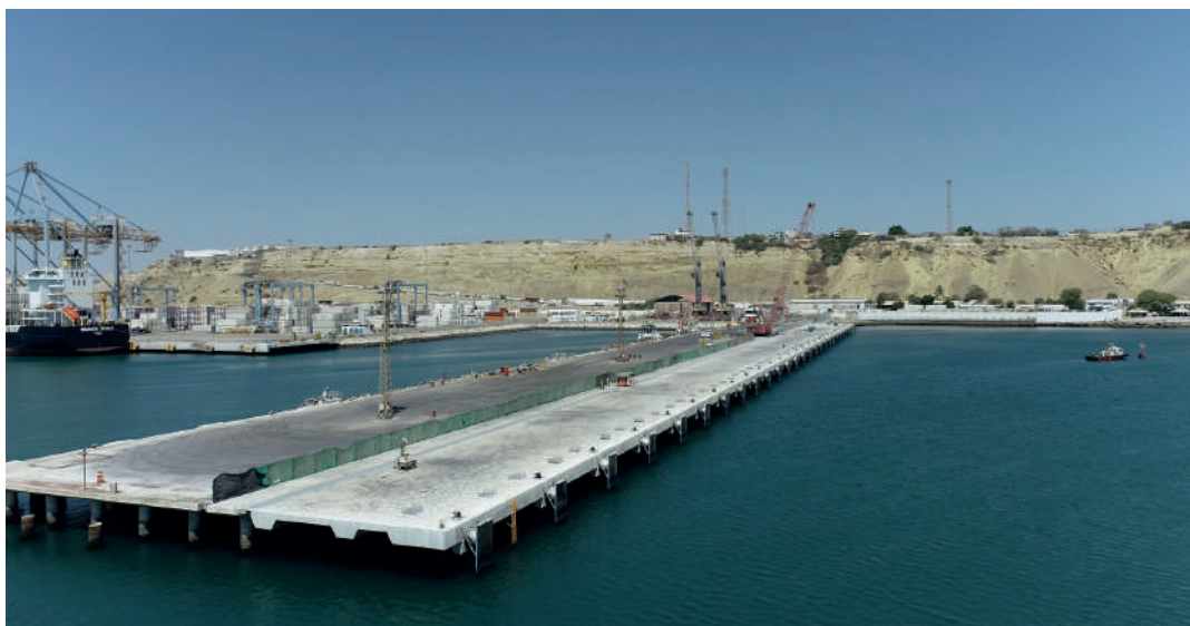
FIG. 3 Vista frontal durante construção. Front view during construction.
