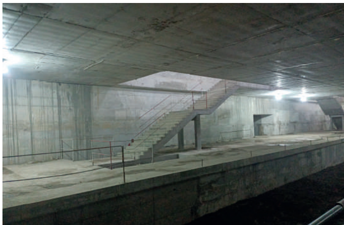
FIG. 2 Estação de Beaulieu – Vista do cais. Beaulieu Station – Quay view.
