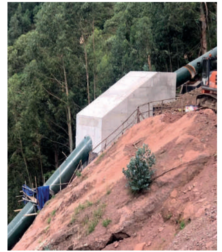
FIG. 3 Conduita forçada em construção. Penstock under construction.
