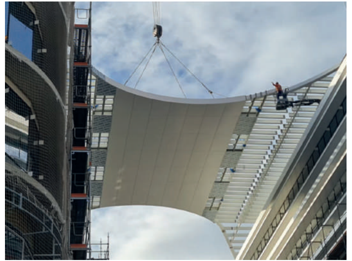
FIG. 3 Fase final da montagem da pala metálica. Steel roof connecting buildings.
