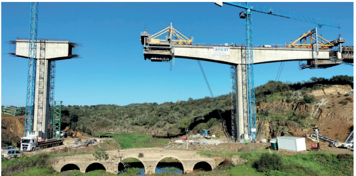
FIG. 2 Processo Construtivo – Execução do Vão Central. Construction procedure – Central Span.
