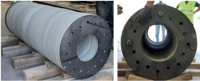
Montagem das peças que materializam o elemento estrutural. Assembly of the parts that make up the structural element.
