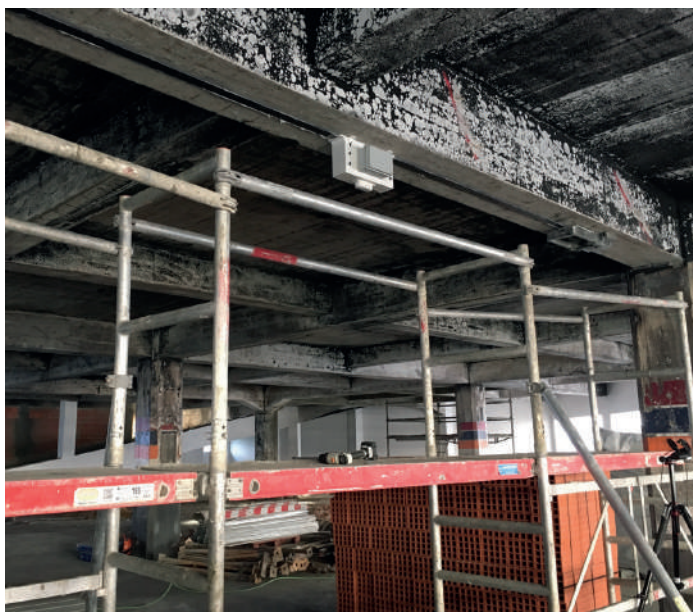
Ensaio de validação em vigas de betão armado com 7 metros de vão. Validation tests on reinforced concrete beams with a 7-meter span.
