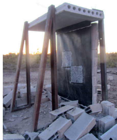
Aspecto final da parede de alvenaria, com proteção contra estilhaços, após a explosão. Final look of the masonry wall, with protection against fragmentation, after the explosion.
