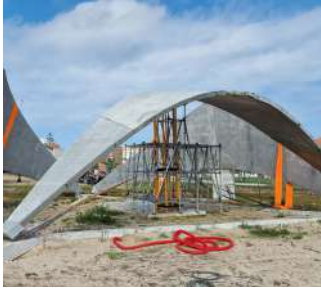
Protótipo instalado na Costa Nova, Ílhavo, Portugal – Montagem. Shell prototype in Costa Nova, Ílhavo, Portugal – Erection.
