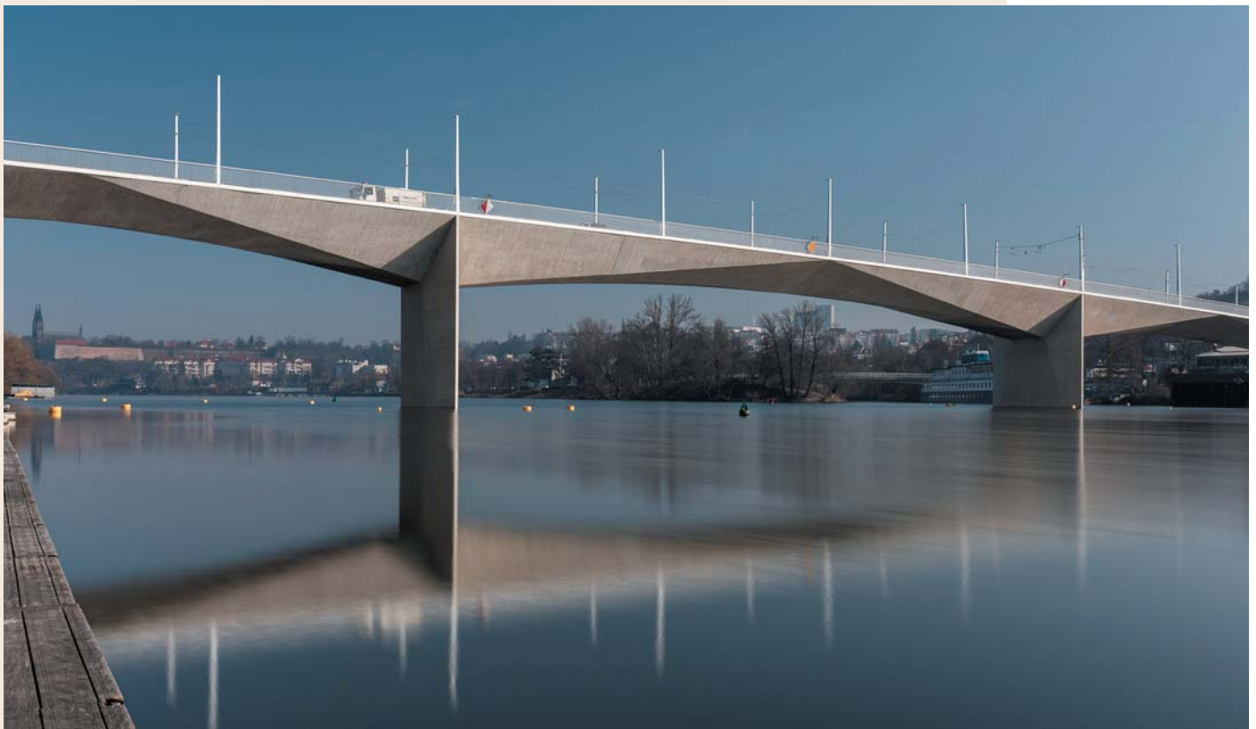
Fig. 20 Completed bridge Obr. 20 Dokončený most
