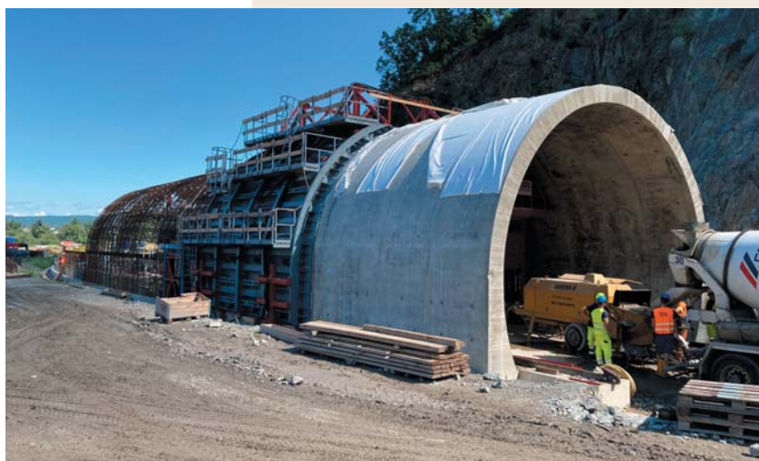
Fig. 1 Tunnel section concrete work and formwork Obr. 1 Betonáž a bednění části tunelu
