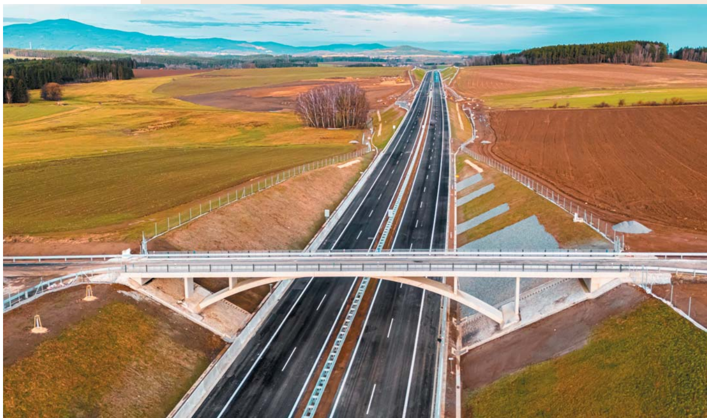
Obr. 4 Dokončený most č. 209 před uvedením do provozu
