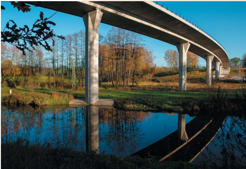
Fig. 1 View of the completed structure Obr. 1 Pohled na dokončenou konstrukci
