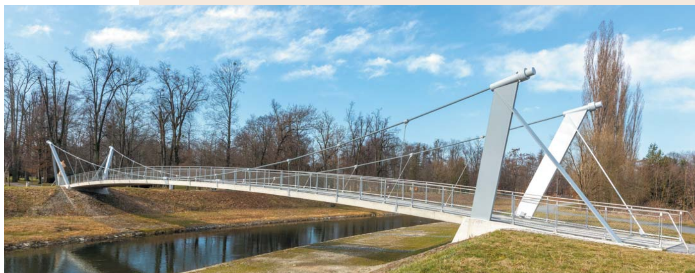
Fig. 1 View of the bridge Obr. 1 Celkový pohled
