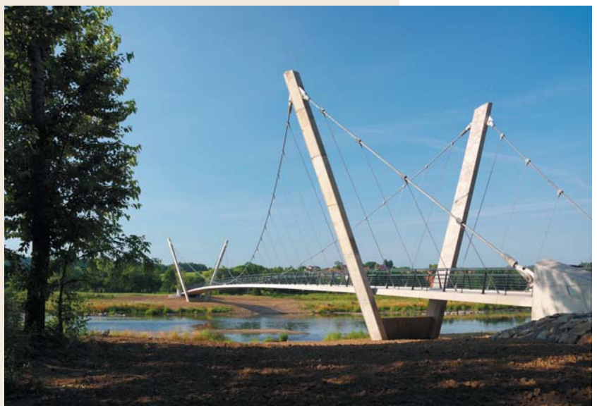
Fig. 5 Bridge structure Obr. 5 Konstrukce mostu
