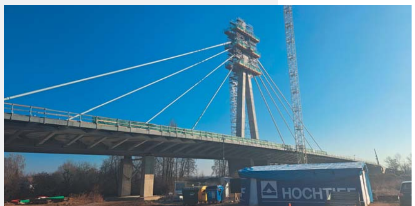
Obr. 5 Montáž závěsů
