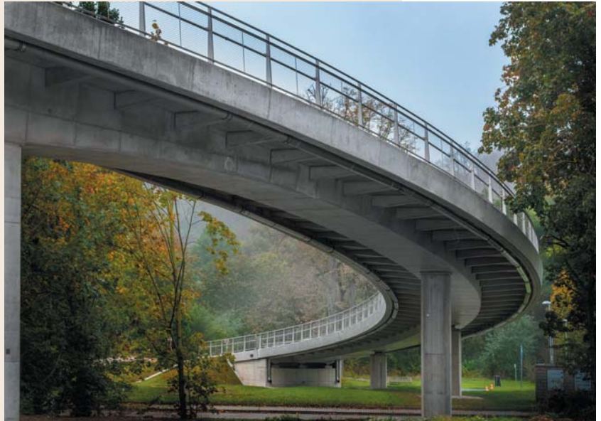
Fig. 4 Riviera footbridge Obr. 4 Lávka Riviéra
