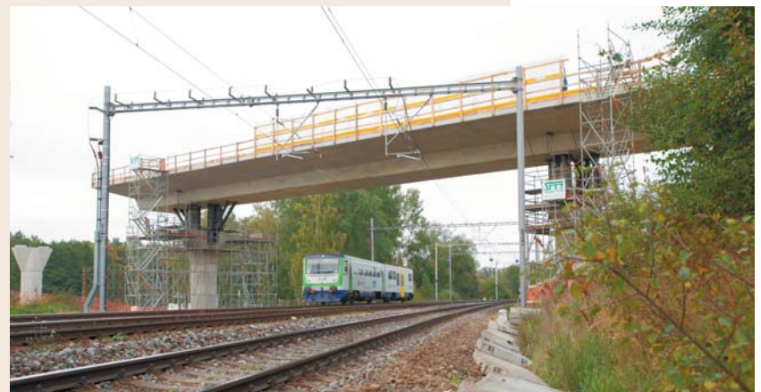
Fig. 6 View of the completed structure Obr. 6 Pohled na dokončenou konstrukci
