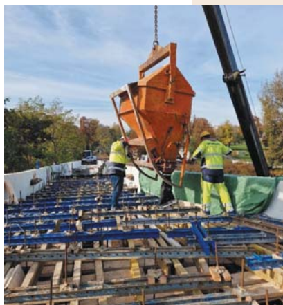
Fig. 15a, b Night concreting of SS – using cranes and buckets Obr. 15a, b Noční betonáž nosné konstrukce – pomocí jeřábů a bádří
