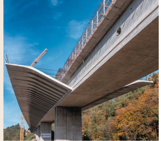
Fig. 4 Spine girder & precast struts
