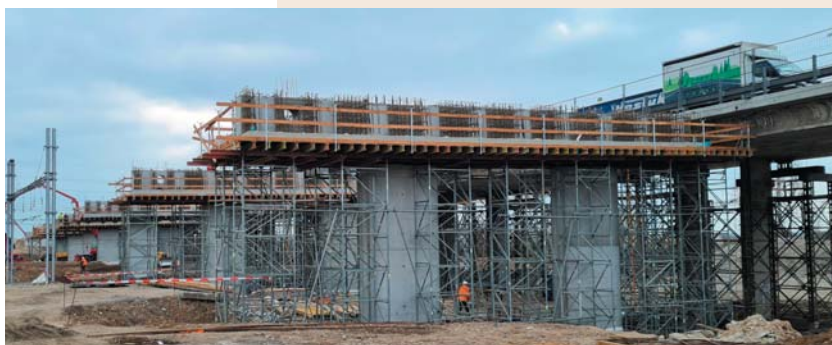
Obr. 7 Osazení nosníků levého mostu
