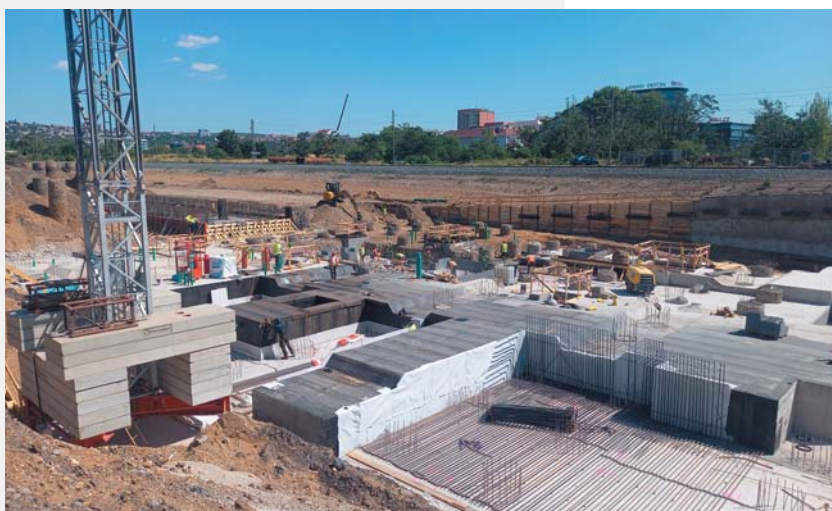
Obr. 3 Podkladní beton a izolace pod členěnou základovou deskou
