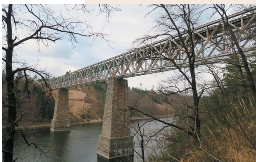
Fig. 1 The old steel railway bridge from 1889 Obr. 1 Starý ocelový železniční most z roku 1889
