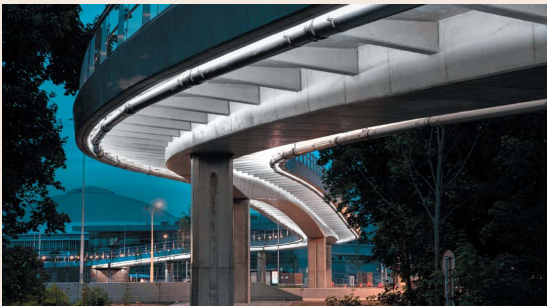
Fig. 5 Riviera footbridge with LED lighting Obr. 5 Lávka Riviéra s LED osvětlením pohledu
