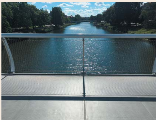
Fig. 6 Railing Fig. 6 Zábradlí
