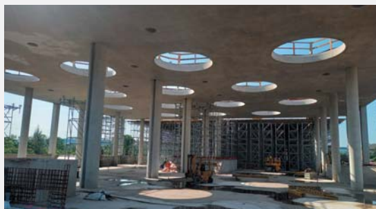
Fig. 5 Scaffolding and supports for the roof slab Obr. 5 Příprava skruže pro desku zastřešení
