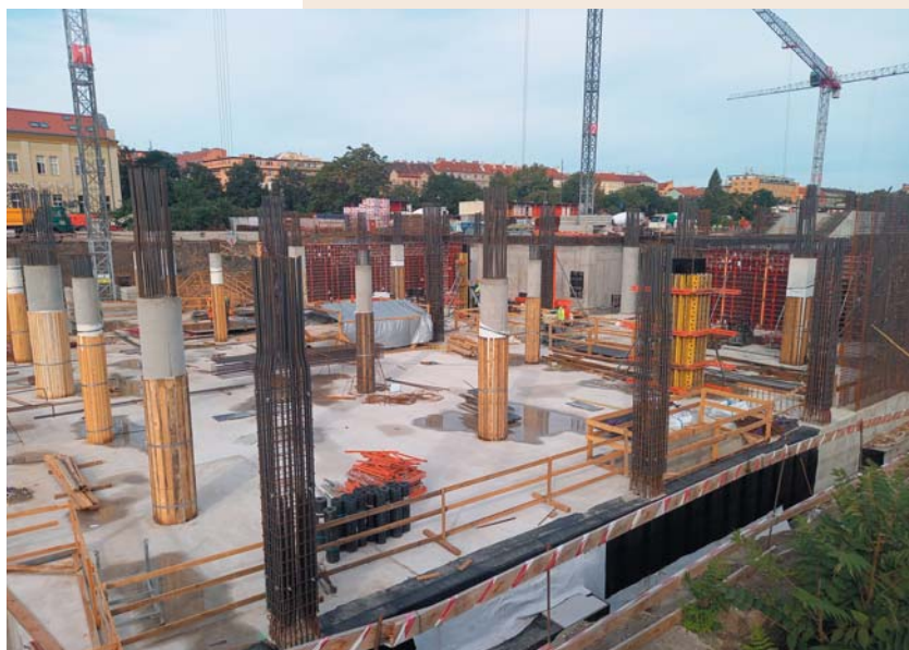
Fig. 4 First floor columns Obr. 4 Sloupy a stěny vestibulů
