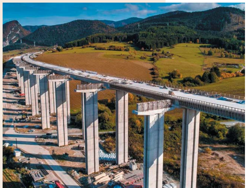
Fig. 5 Beams and pier caps Obr. 5 Nosníky a hlavice pilířů
