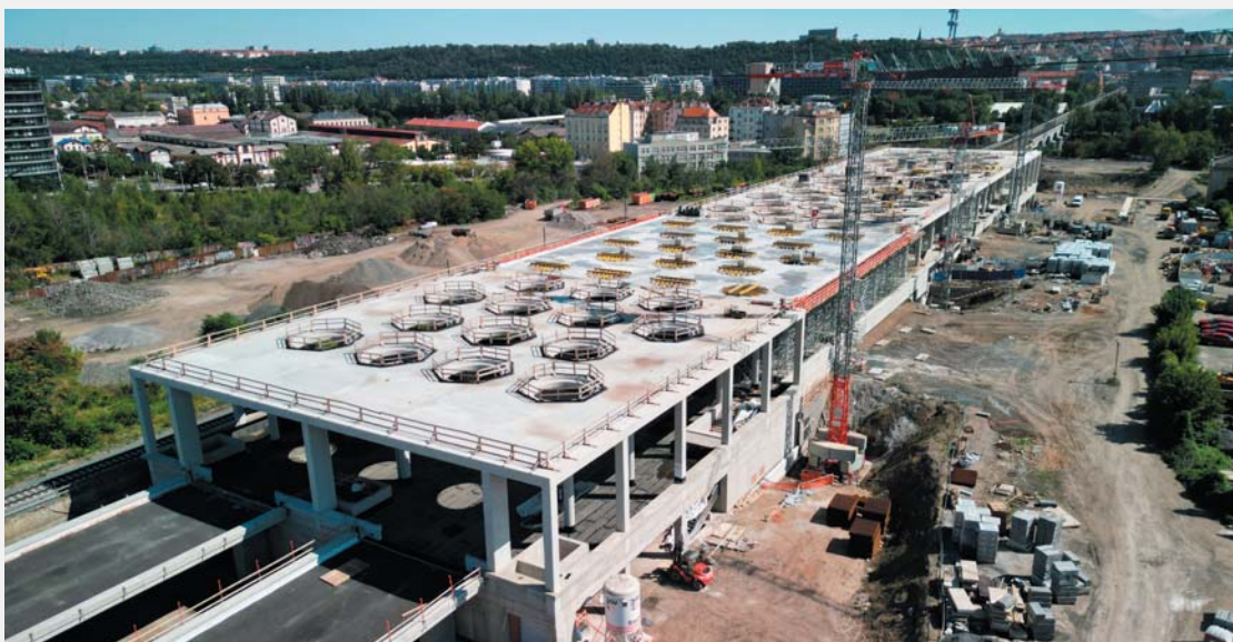
Fig. 8 Finished roof structure Obr. 8 Dokončená nosná konstrukce
