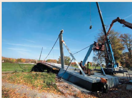
Fig. 7 Tensioning of suspension cables Obr. 7 Napínání visutých kabelů
