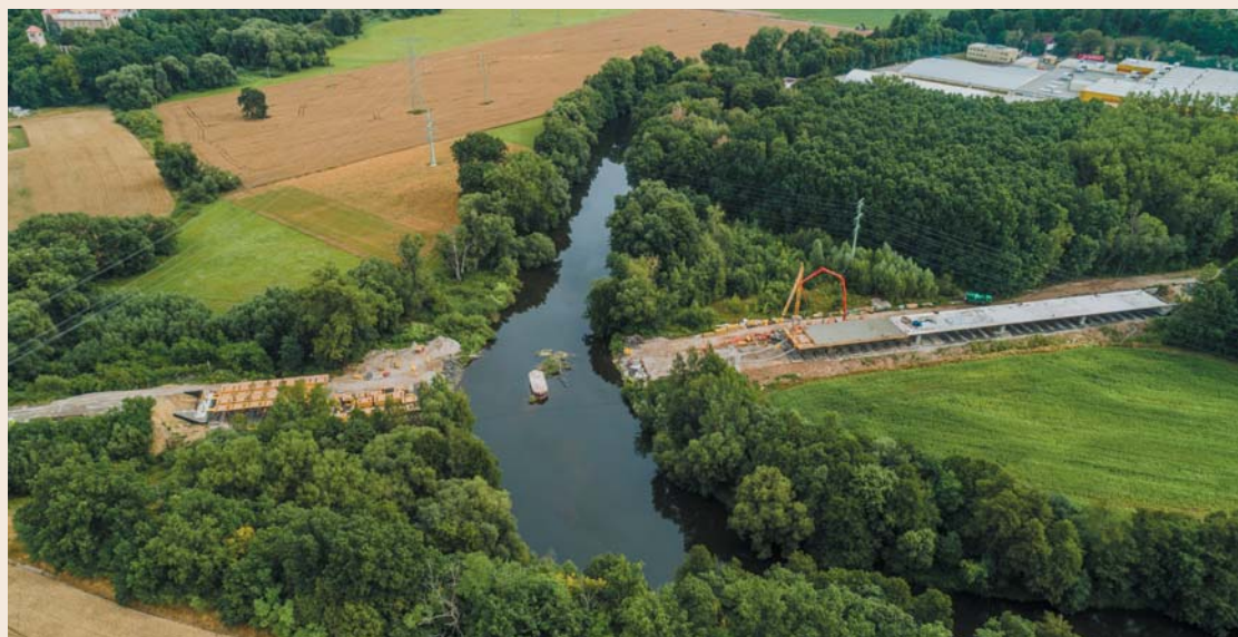
Fig. 6 Overview of the site Obr. 6 Celkový pohled na staveniště
