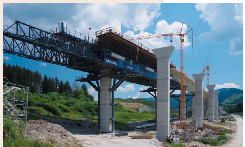
Fig. 4 Movable scaffolding Obr. 4 Výsuvná skruž
