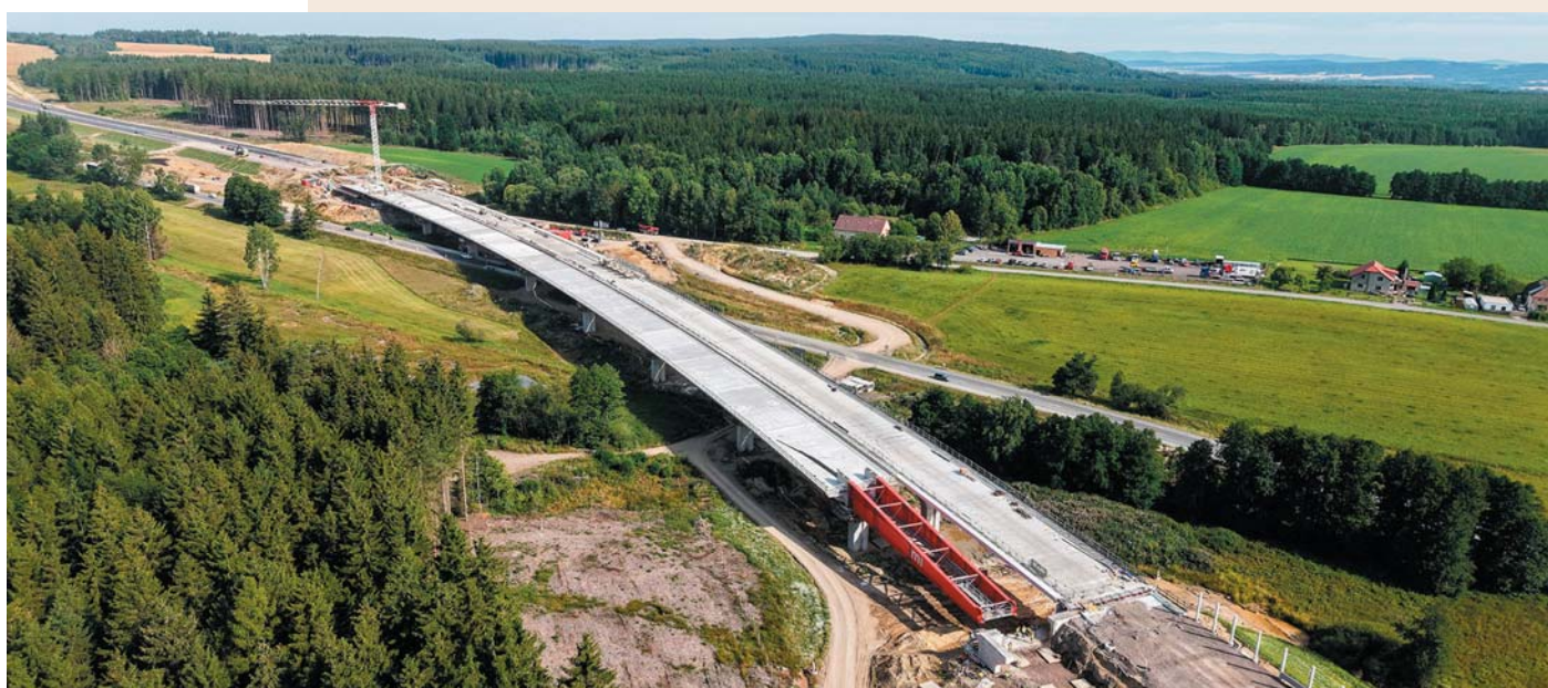
Fig. 1 Bridge incremental launching Obr. 1 Postupné vysouvání mostu
