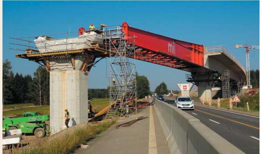
Fig. 2 Launching over the Litomyšl – Moravská Třebová Highway
