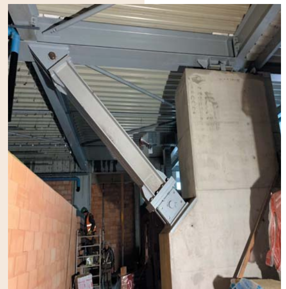
Fig. 5 Column with a brace – support of steel trusses Obr. 5 Pilíř se vzpěrou – podepření ocelových vazníků
