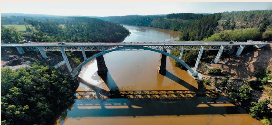
Fig. 2 The new concrete arch bridge Obr. 2 Nový betonový obloukový most
