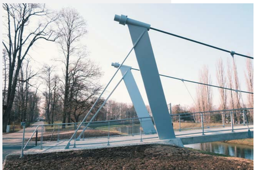
Fig. 5 Steel pylons
