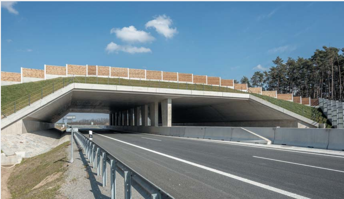
Fig. 6 Completed bridge Obr. 6 Dokončený most
