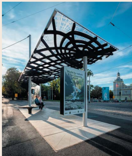
Fig. 6 Roof structure Obr. 6 Konstrukce střešky
