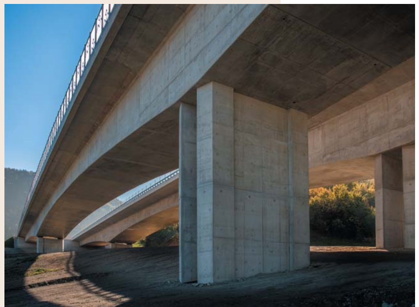
Fig. 4 Bridge structure Obr. 4 Konstrukce mostu
