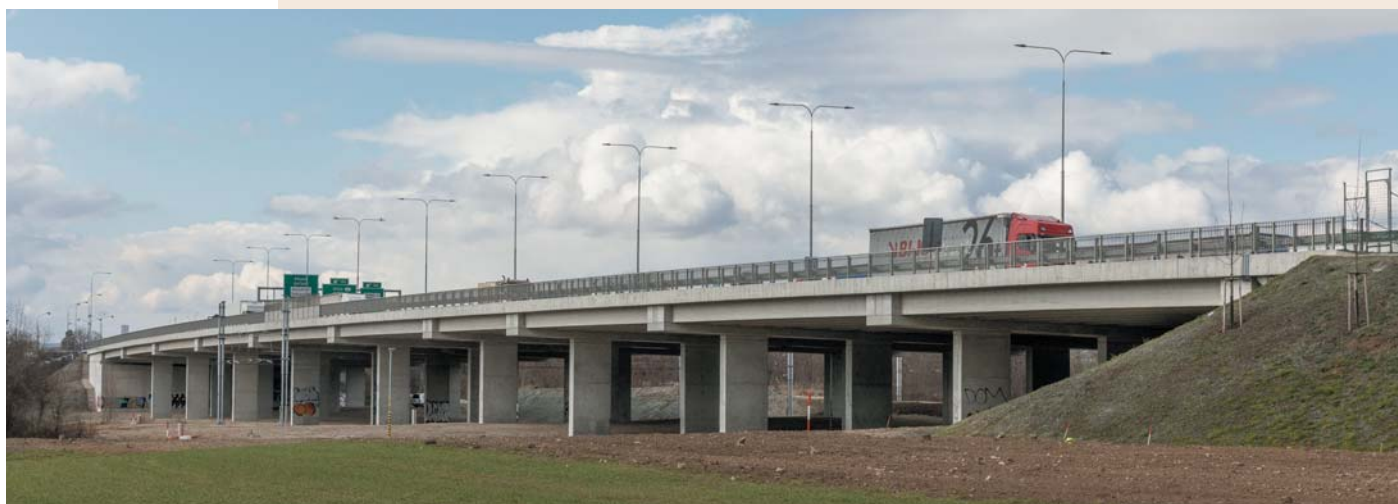
Fig. 1 View of the bridge Obr. 1 Celkový pohled
