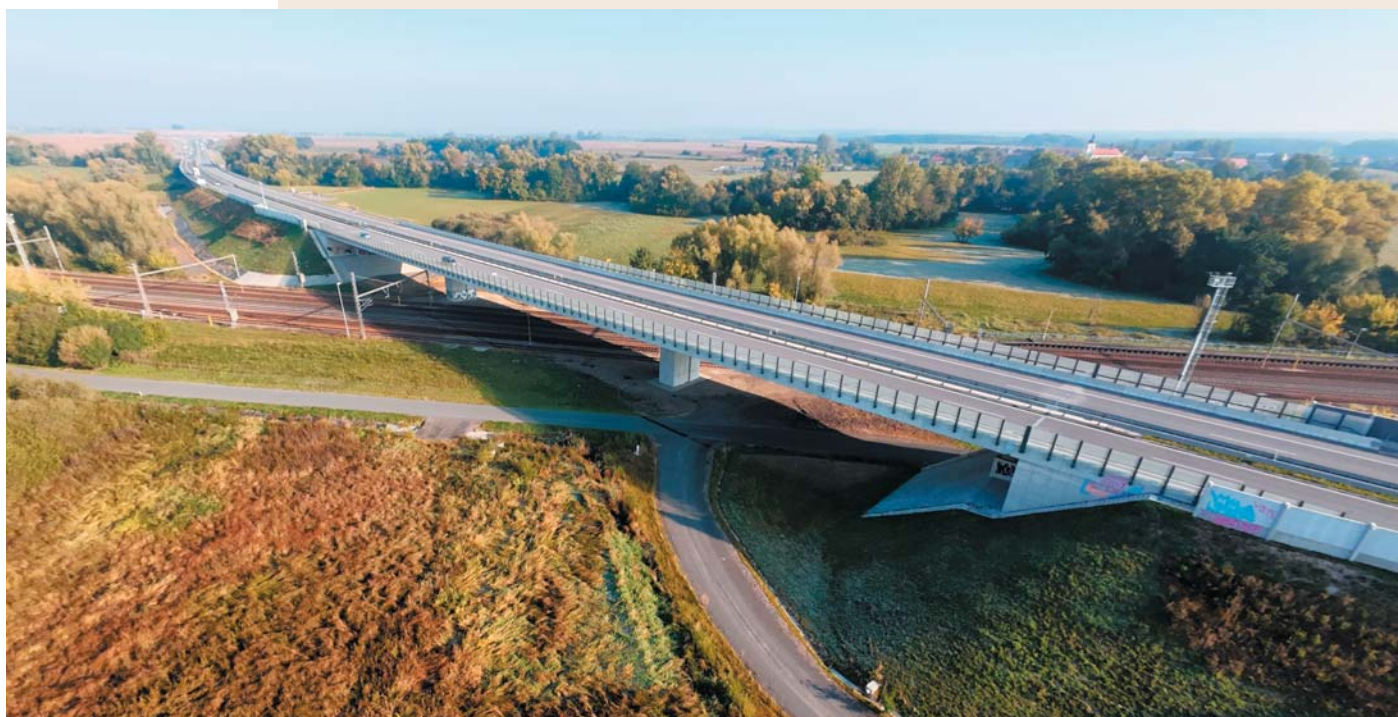
Fig. 1 View of the bridge Obr. 1 Celkový pohled
