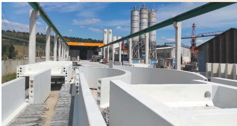
Obr. 7 Vybetonované prvky parapetů, segmenty
