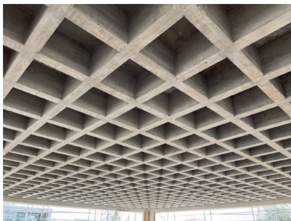
Fig. 9 Il campo quadrato grande del solaio a cassettoni in fase di cantiere. The large square area of the coffered slab during construction.
