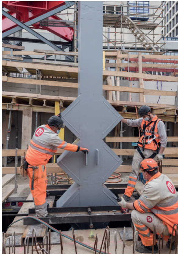
Fig. 6 Einlegeteil zur Einleitung der Zug- und Druckkräfte aus den VKT-Stützen. Insert for introducing tensile and compressive forces from the steel columns. (© Beat Bühler)
