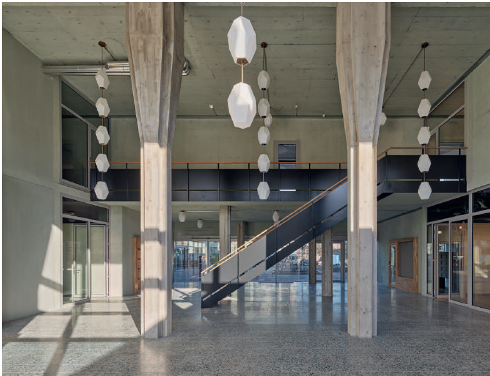
Fig. 12 Zweigeschossiges Foyer mit Sichtbetonstützen. Two-storey foyer with exposed concrete columns. (© Ariel Huber)
