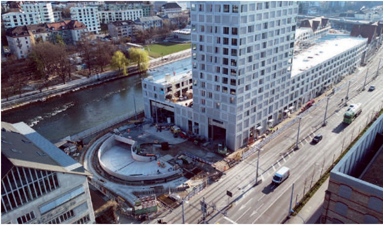
Fig. 2 Einfahrt ins Depot für Tram (im EG) und Fahrrad und Auto (UG) von der Westseite. Entrance to the depot for tram (GF) and bicycle and car (basement) from the west side.
