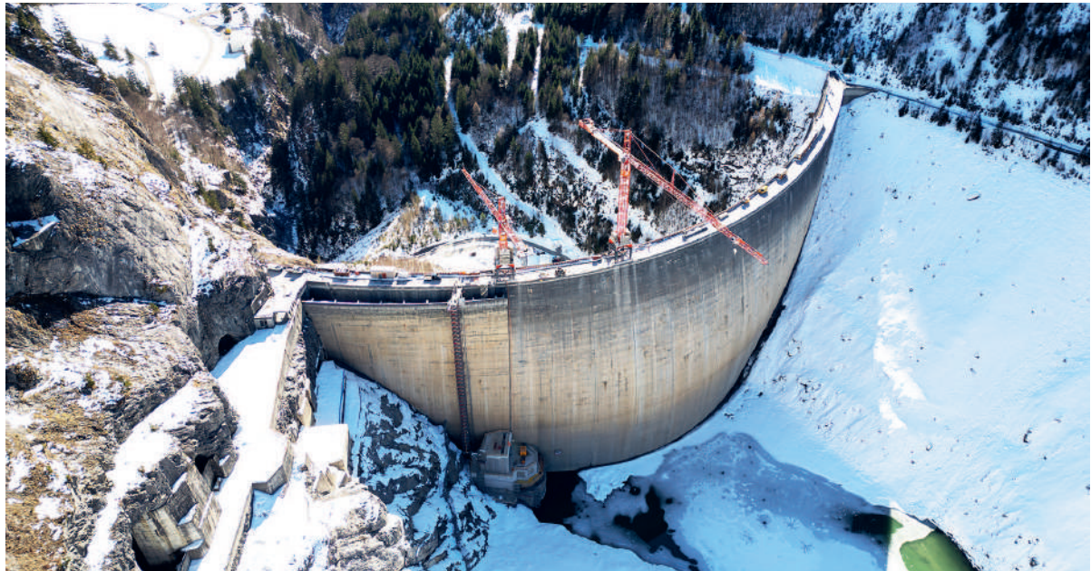
Fig. 1 Gesamtansicht während Bauarbeiten. General view during works.
