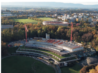
Fig. 1 Die Erweiterung im Bau. The extension under construction. (© FHV Architectes)
