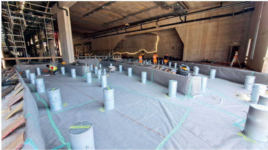
Fig. 9 Masse-Feder-System auf Stahlfedern: Herstellung. Mass-Spring-System on steel springs under construction.
