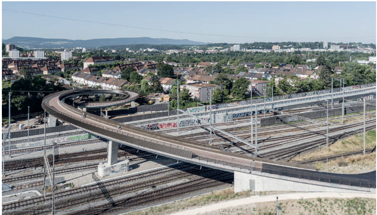
Fig. 7 Passerelle Hagnau. Footbridge Hagnau. (© Beat Bühler)
