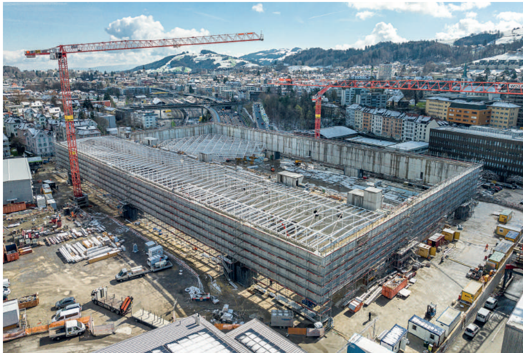
Fig. 6 Die SGKB-Halle nach Abschluss des Betonbaus. The SGKB Hall after completion of the concrete construction. (© Foto-huwi.ch)
