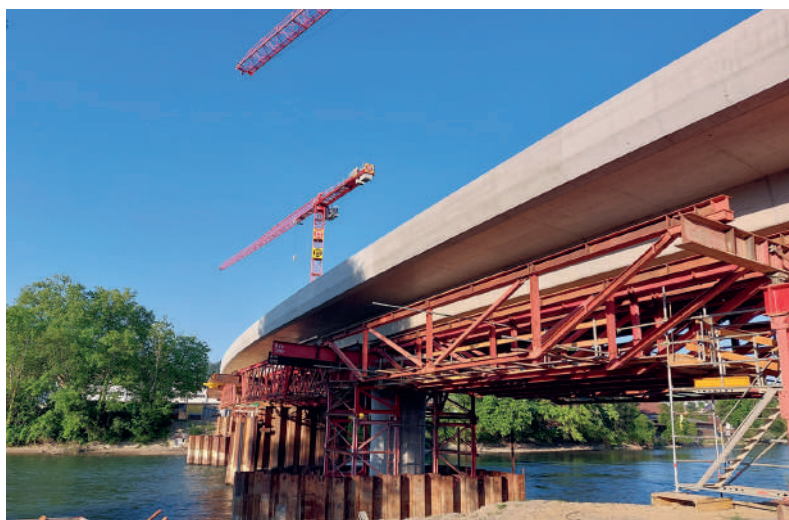
Fig. 8 Lehrgerüst abgesenkt/Betonarbeiten abgeschlossen. Falsework lowered/concrete work completed.
