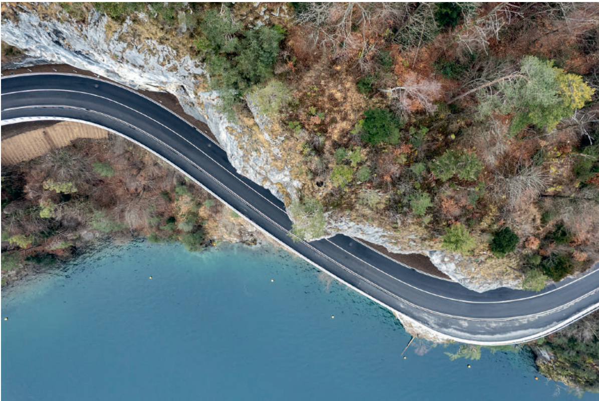
Fig. 2 Lehnenkonstruktion Ober Nas aus der Vogelperspektive. Slope-supported viaduct Ober Nas – bird's eye view.
