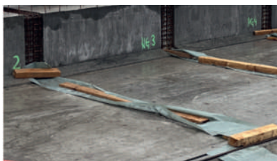
Fig. 8 Ausgiessen der Stossfuge. Casting the butt joint.
