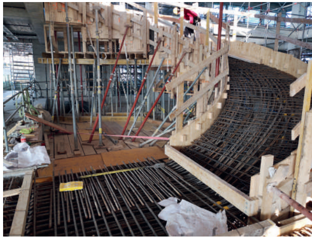
Fig. 11 Erstellung der Wendeltreppe. Construction of the helical stair.
