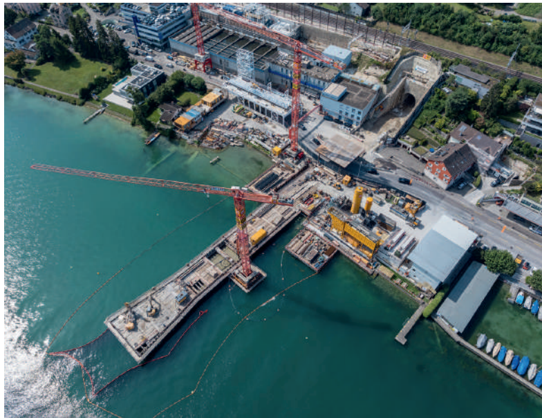
Fig. 6 Luftaufnahme des Stollenmunds (vor Aushub des Tosbauwerks) und der Arbeiten am Auslaufkanal (Aug. 2024). Aerial view of the gallery outlet (prior to excavating the dissipation chamber) and the channel construction (Aug. 2024). (© AWEL)
