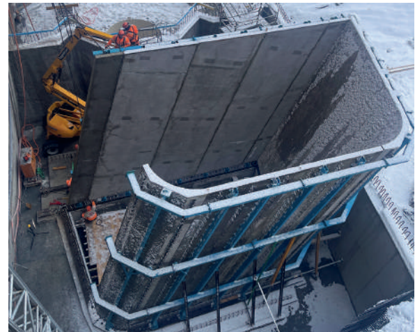
Fig. 5 Ansicht der vorgefertigten Elemente des Schachts. View of the shaft precast elements.
