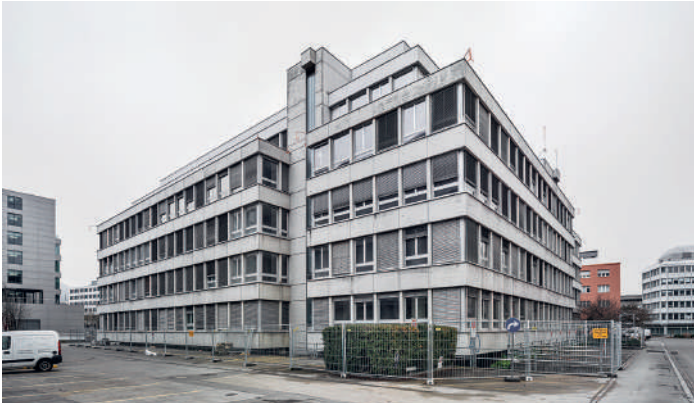
Fig. 2 Das Gebäude vor Beginn der Arbeiten. The building before work began. (© René Dürr, Zürich)
