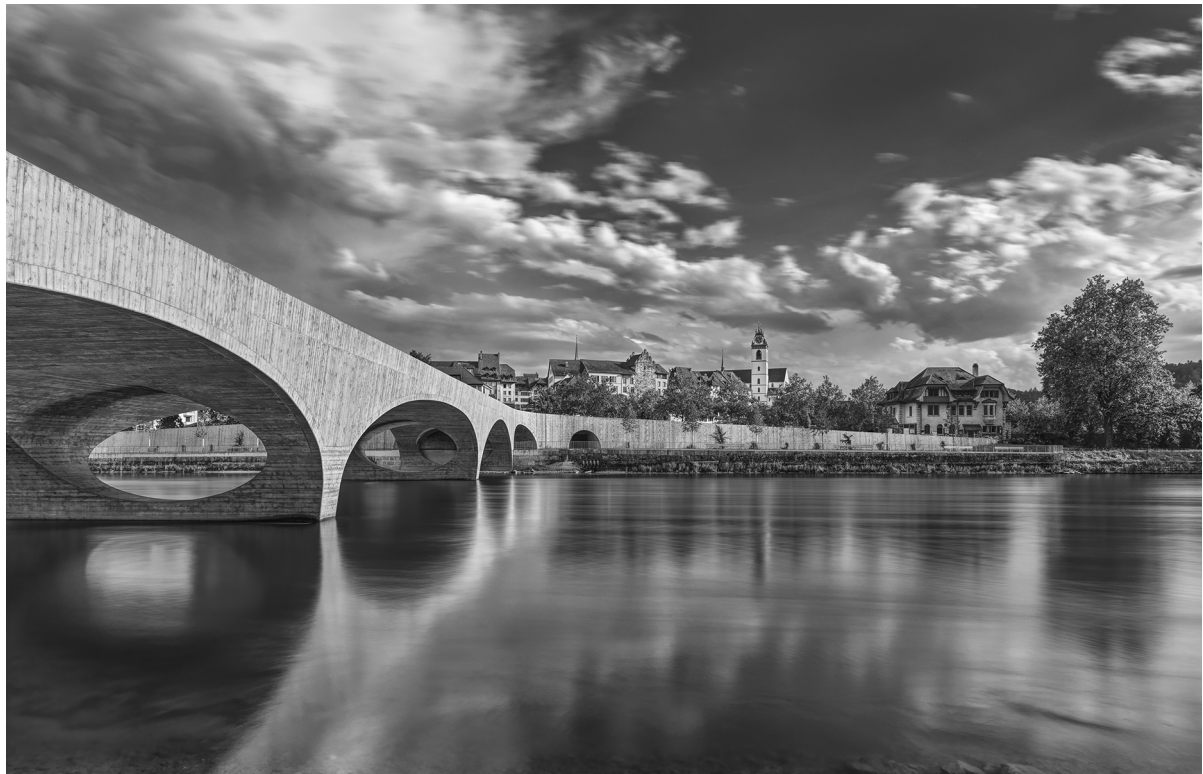
Fig. 9 Oberwasserseitige Flanke und Brückenuntersicht, Blick vom Nordufer in Richtung Süden. Upstream flank and underside of the bridge, view from the north bank towards the south. (© WMM Ingenieure AG, Luca Ferrario)
