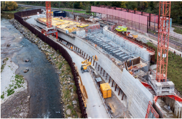
Fig. 2 Einlaufbauwerk im Bau (Okt. 2024) mit architektonisch gestalteter Tauchwand. Intake structure under construction (Oct. 2024) with architecturally designed skimming wall. (© AWEL)
