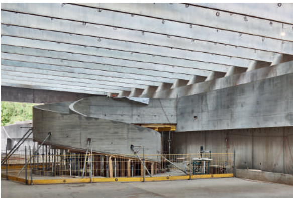
Fig. 7 Innenansicht des Lesesaals im Bauzustand mit der Wendeltreppe. Interior view of the reading room under construction, with the spiral stair. (© Daniela Tonatiuh)
