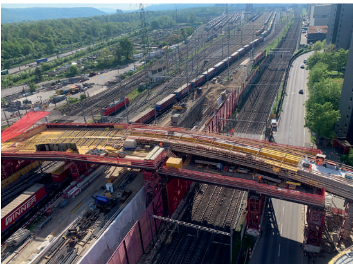
Fig. 10 Bauzustand Passerelle Hagnau. Construction stage of the footbridge Hagnau.
