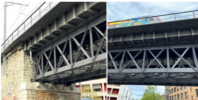
Fig. 1 Ansicht einer Wipkinger Stahlbrücke mit UHFB-Trog [1]. View of a Wipkinger steel bridge with UHPC trough [1].
