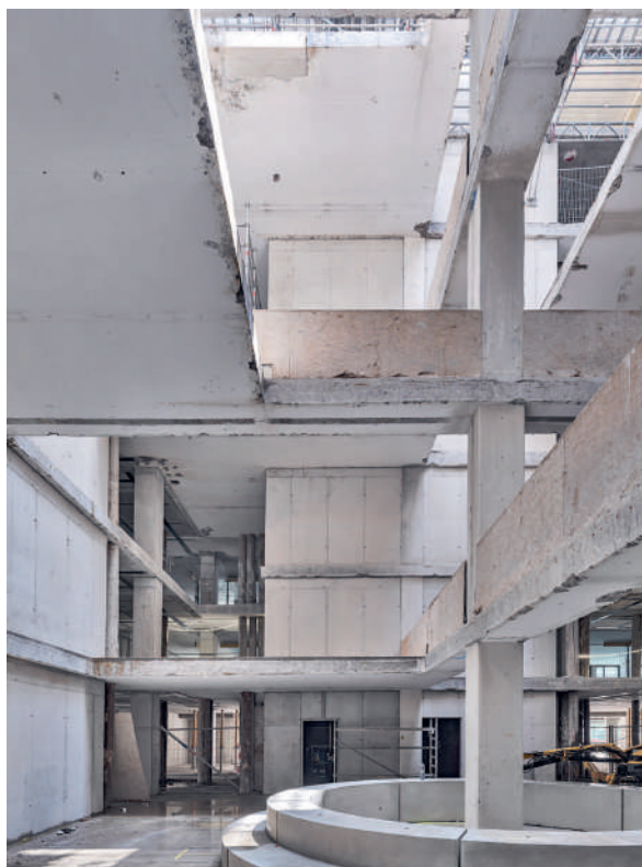
Fig. 4 Der Innenhof vor dem Ausbau. The atrium before the extension. (© René Dürr, Zürich)
