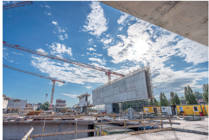
Fig. 4 Hohlkastenträger im Bauzustand. Box girder in construction state. (© Foto-huwi.ch)
