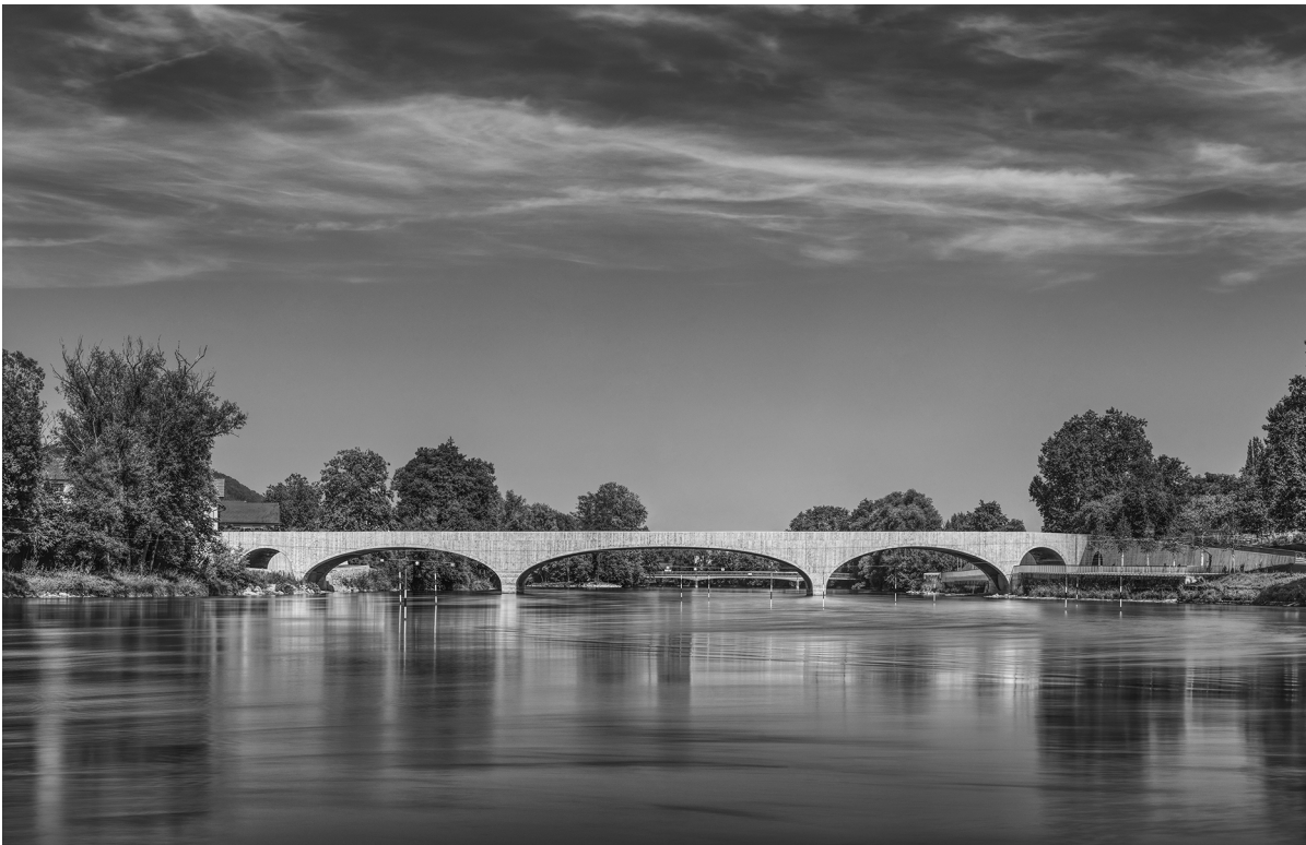
Fig. 10 Gesamtes Brückenbauwerk, Blick flussabwärts. Entire bridge structure, view downstream. (© WMM Ingenieure AG, Luca Ferrario)
