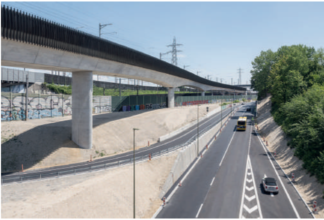
Fig. 2 Donnerbaumbrücke. Donnerbaum bridge. (© Beat Bühler)
