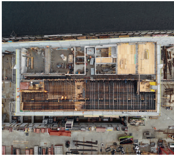
Fig. 6 Hochhaus Nord. Erstellung der ins Hochhaus hineinragenden vorgespannten Depotdecke über OG2. North tower. Construction of the post-tensioned depot slab extending into the high-rise structure above Level 2.
