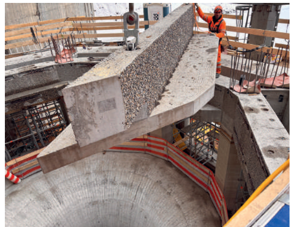
Fig. 9 Ansicht der vorgefertigten Elemente des Grundablasses. View of the bottom outlet precast elements.
