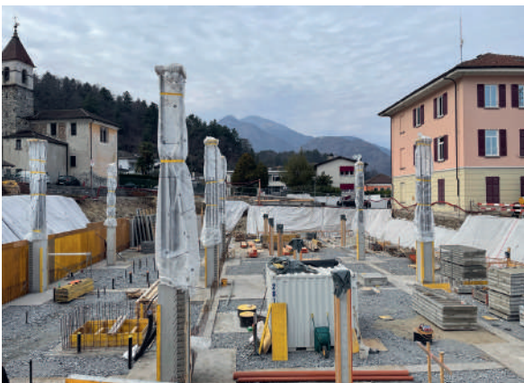
Fig. 7 Il cantiere con le fondazioni e i pilastri del piano interrato. The construction site with the foundations and pillars of the basement.
