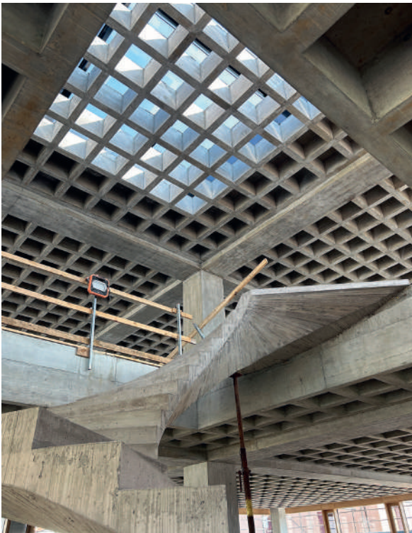
Fig. 11 Il pianerottolo della scala al secondo piano e il solaio di copertura a struttura ultimata. The landing on the second-floor staircase and the roof slab once structure completed.
