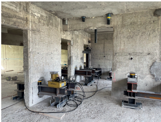
Fig. 9 Notspriessung mit hydraulischen Pressen. Temporary supports with hydraulic presses.
