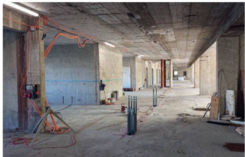
Fig. 5 Anschlussbewehrung der neuen Längswände. Connection reinforcement of the new longitudinal walls.
